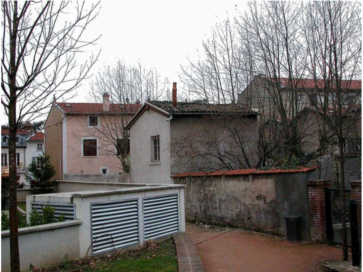
Façade arrière du logis et resserre
