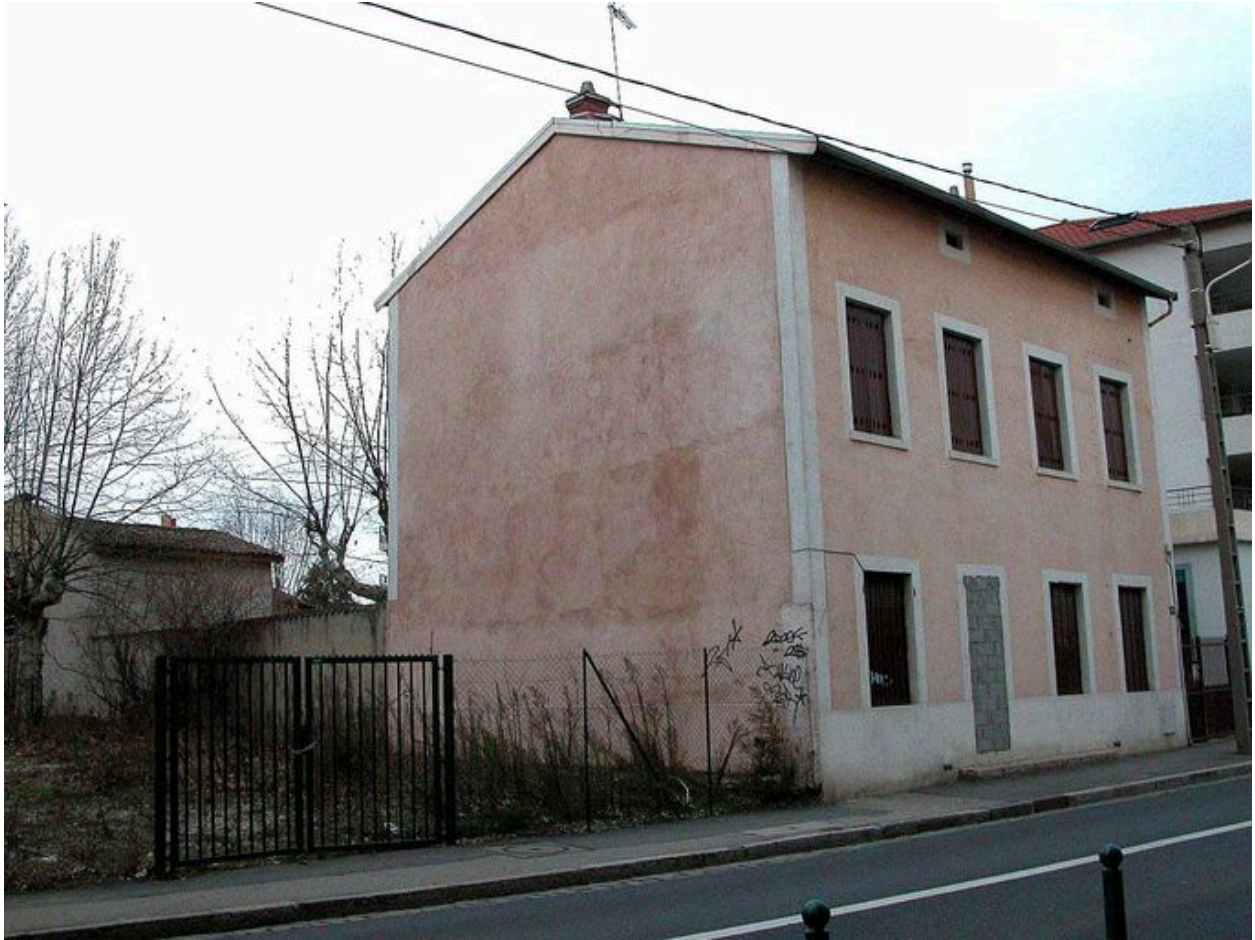
Vue générale depuis la rue, côté ouest
