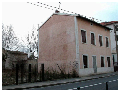
Vue générale depuis la rue, côté ouest Phot. Véronique Belle IVR82_20046901002NUCA
