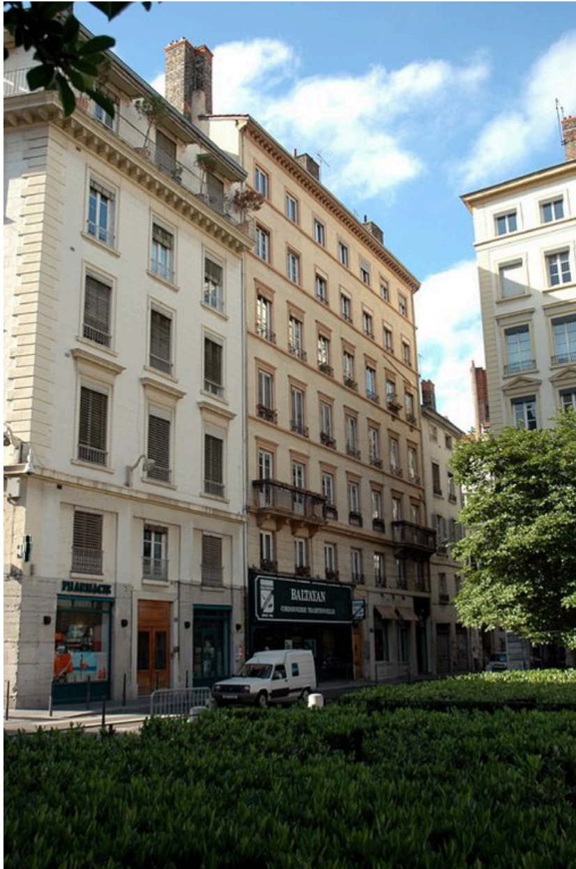
Elévation antérieure place des Célestins
