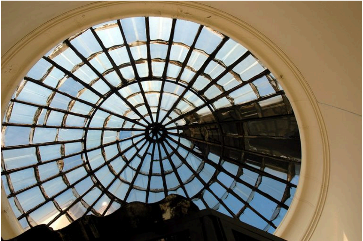
La cage d'escalier : le "ciel ouvert"
