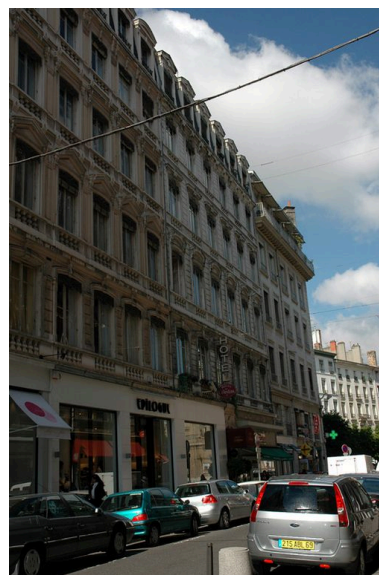
Elévation latérale rue des Archers
