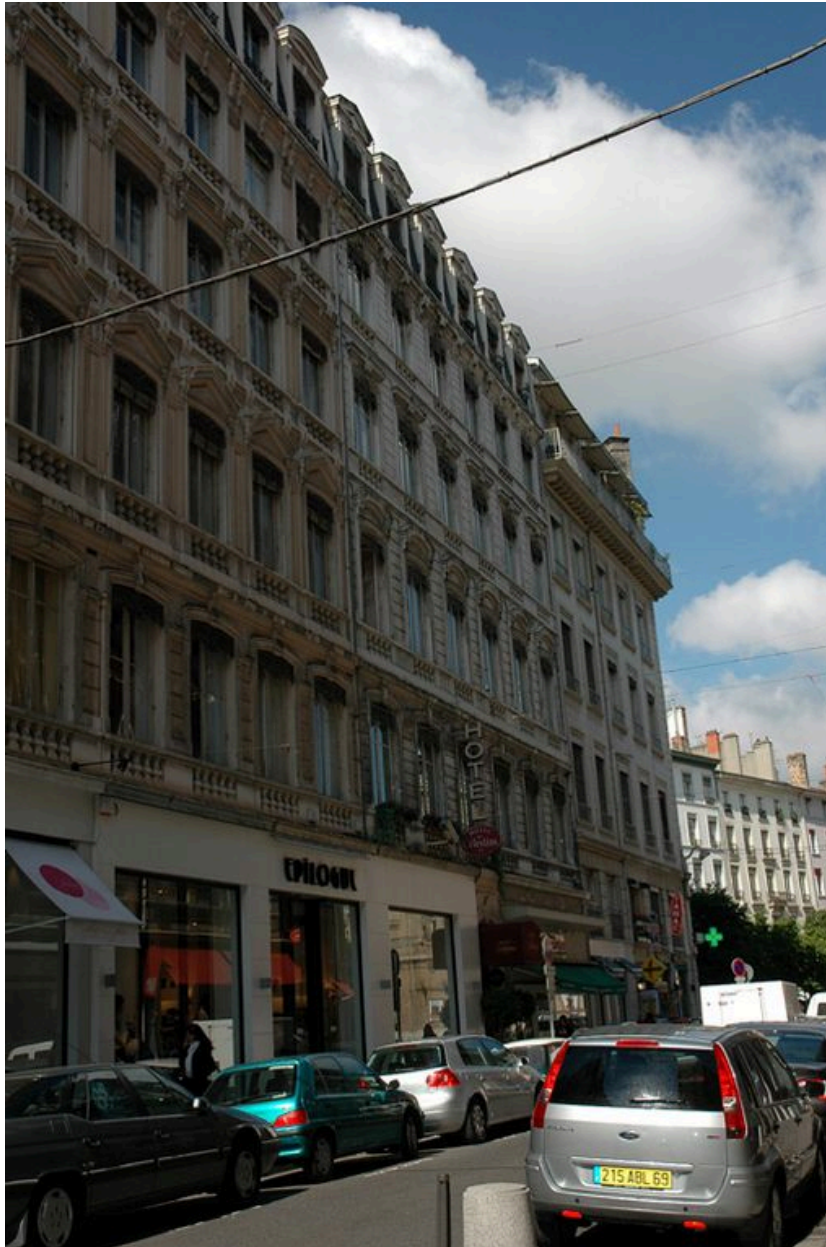
Elévation latérale rue des Archers
