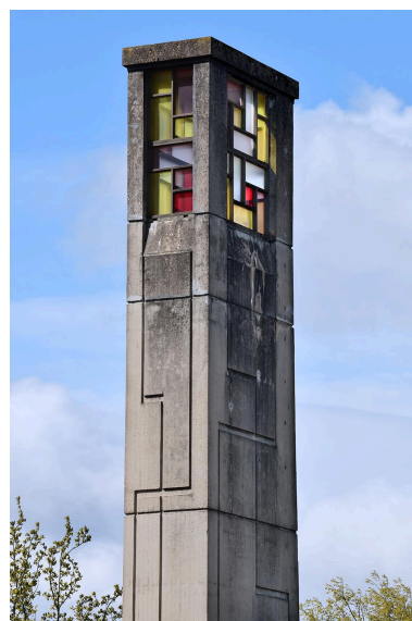
Détail de la partie vitrée de la lanterne Phot. Thierry Leroy IVR84_20266900474NUCAQ
