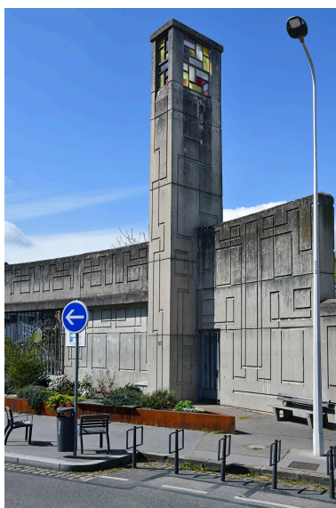
La lanterne des morts depuis le nord Phot. Thierry Leroy IVR84_20266900471NUCAQ
