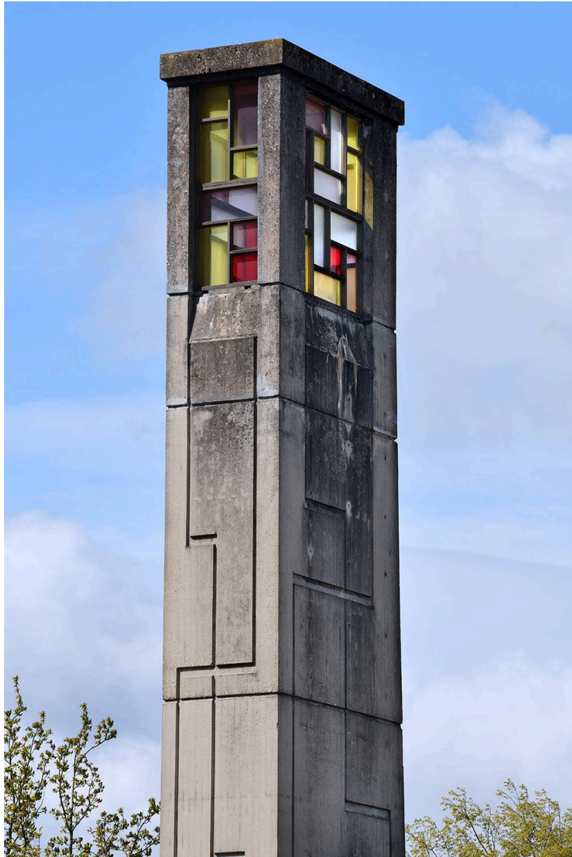
Détail de la partie vitrée de la lanterne
