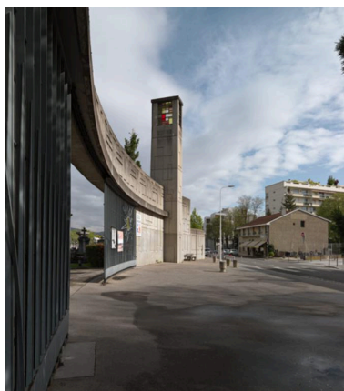
Vue générale en 2012 Phot. Eric Dessert IVR82_20126901425NUCA
