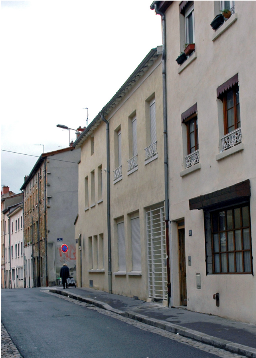
Vue générale depuis le sud-ouest
