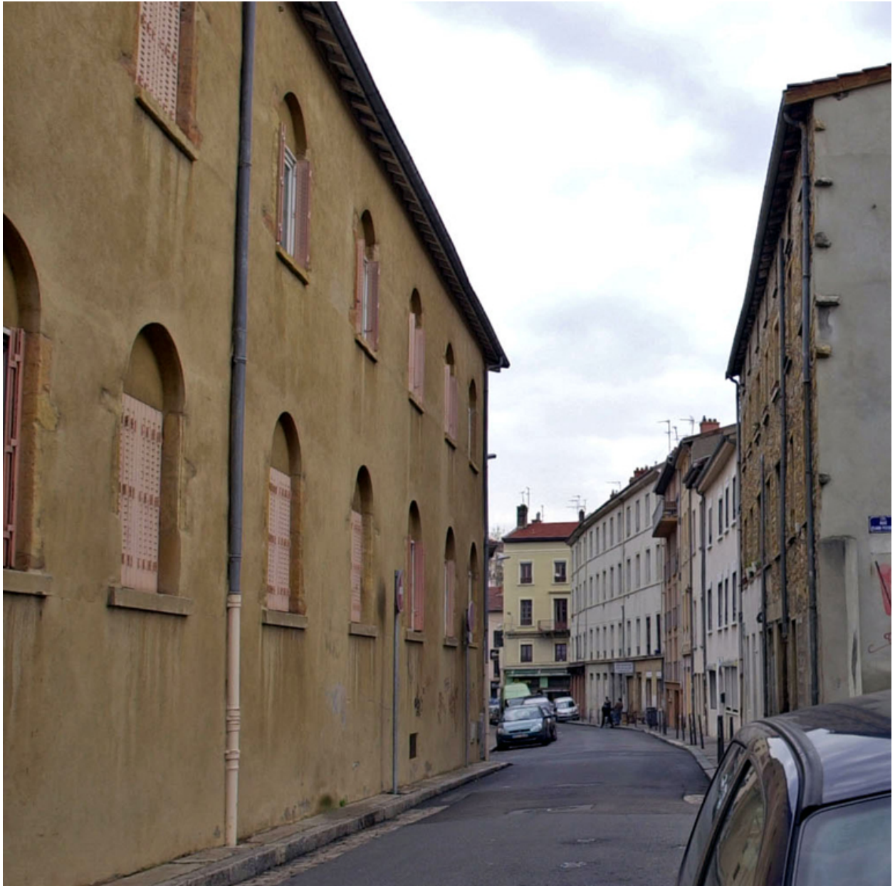
Élévation est, rue Claude-Boyer, vue partielle
