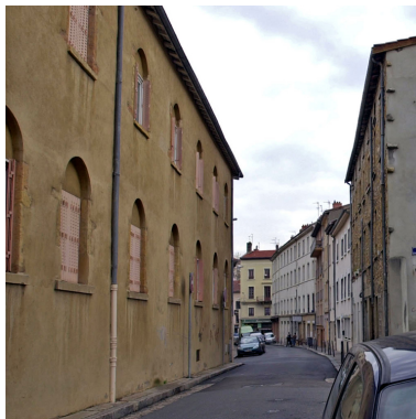
Elévation est, rue Claude- Boyer, vue partielle Phot. Maryannick Chalabi IVR82_20126903111NUCA
