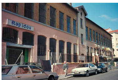
Vue d'ensemble nord-est Phot. Nadine Halitim-Dubois IVR82_20016900547ZA
