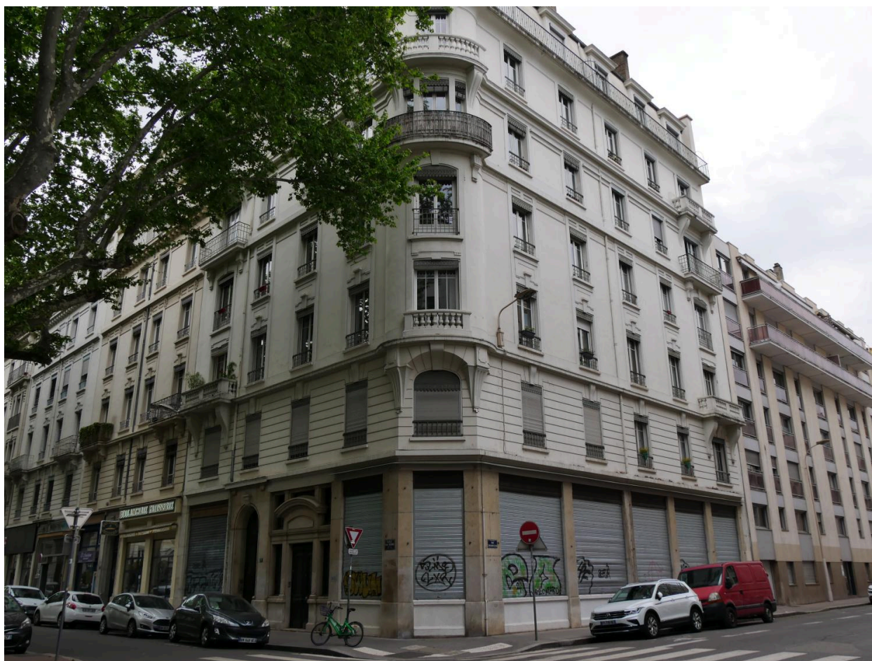
Vue d'ensemble ancienne usine Bergès en rez-de-chaussée
