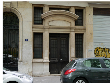
Porte de l'usine et bureaux papeteries Bergès avec enseigne Phot. Nadine Halitim-Dubois IVR84_20246900409NUCA
