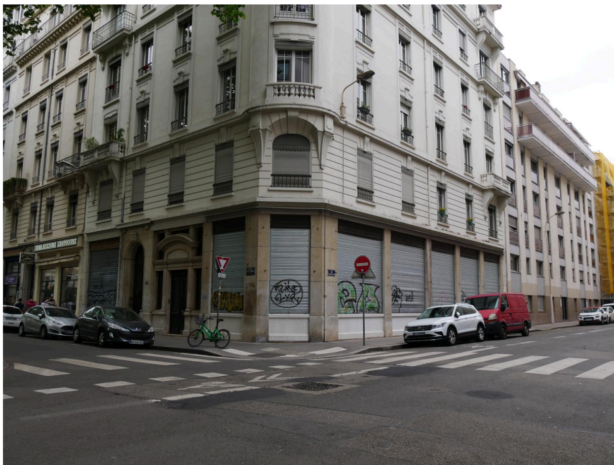
Vue d'ensemble rez-de-chaussée usine Bergès-Lyon
