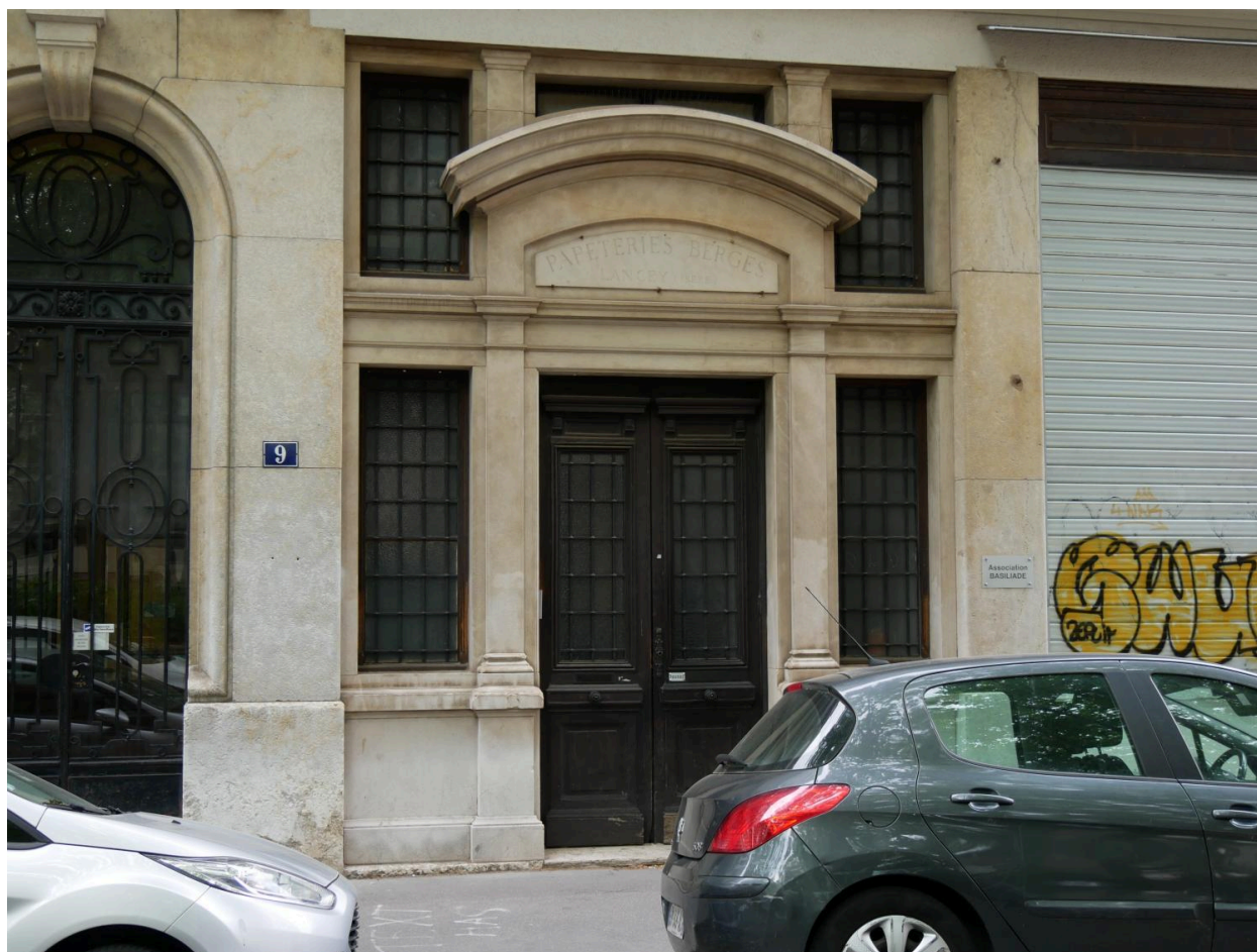
Porte de l'usine et bureaux papeteries Bergès avec enseigne
