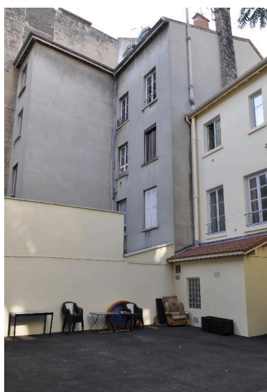
Vue générale des élévations sur cour Phot. Catherine Guégan IVR82_20156902509NUCA
