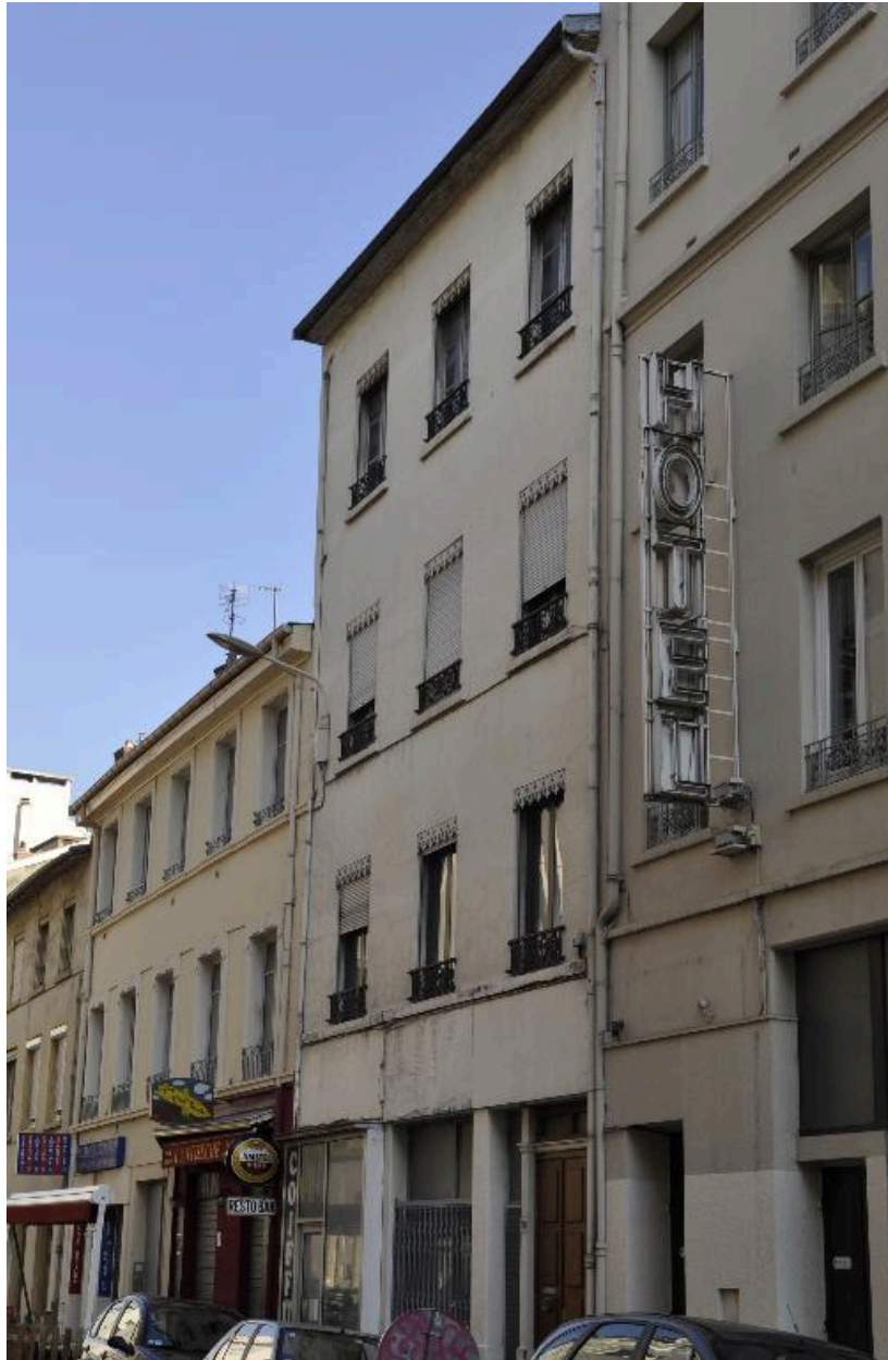
Vue générale de l'élévation sur rue
