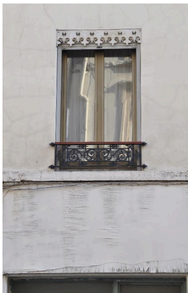
Élévation sur rue : détail d'une fenêtre Phot. Catherine Guégan IVR82_20156901171NUCA
