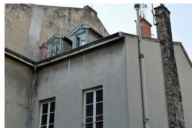
Élévation sur cour : vue rapprochée du couronnement et des combles Phot. Catherine Guégan IVR82_20156901172NUCA
