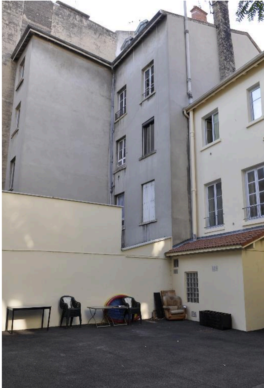
Vue générale des élévations sur cour
