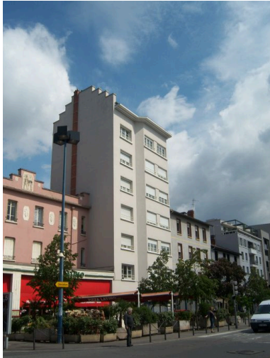
Vue de situation Phot. Salohy Rakotomalala IVR82_20106901454NUCA
