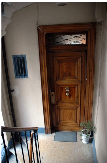
Porte palière Phot. Véronique Belle IVR82_20086902904NUCA
