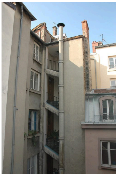
Elévations sur cour depuis la cour de l'immeuble sis 8 rue Ferrandière Phot. Véronique Belle IVR82_20086902080NUCA
