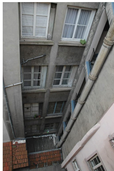
Elévation sur cour Phot. Véronique Belle IVR82_20086902081NUCA
