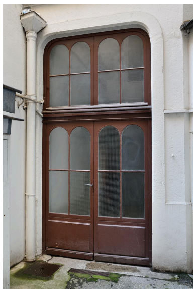
Porte donnant sur la cour commune Phot. Thierry Leroy IVR84_20266900586NUCAQ
