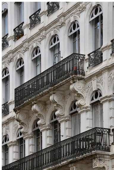
Balcon du troisième étage carré Phot. Thierry Leroy IVR84_20266900581NUCAQ
