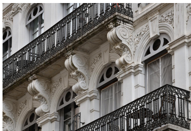
Consoles soutenant le balcon du troisième étage carré Phot. Thierry Leroy IVR84_20266900584NUCAQ
