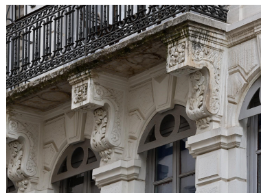
Consoles : détail Phot. Thierry Leroy IVR84_20266900580NUCA
