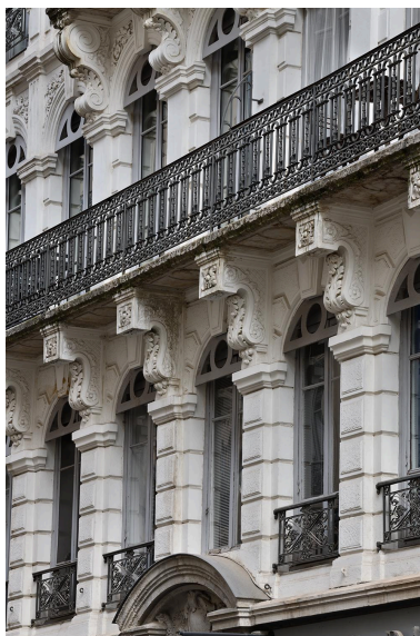
Consoles soutenant le balcon du deuxième étage carré Phot. Thierry Leroy IVR84_20266900578NUCAQ
