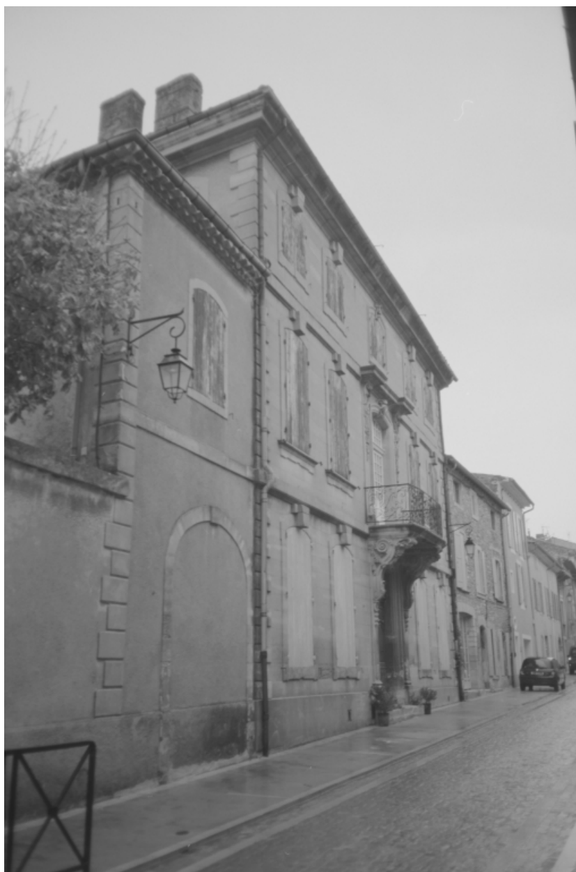
Façade sur rue, prise depuis l'ouest , avec dépendance accolée ; la porte cochère (murée) est datée à la clef 1767.
