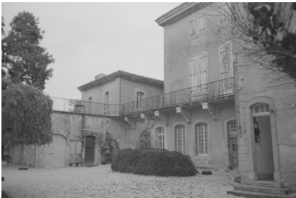
Vue partielle des élévations sur jardin, prise depuis le sud-ouest.
