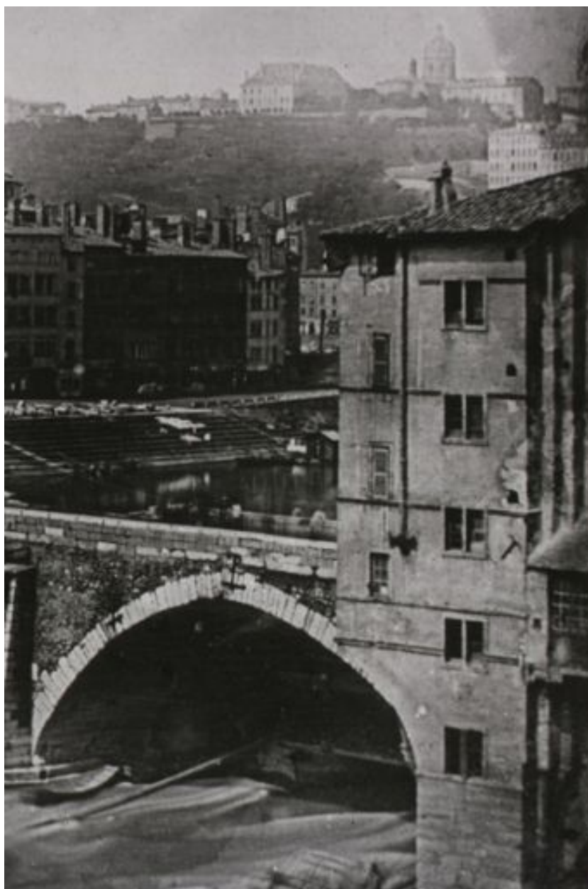
Le Pont de Pierre lors de la construction du nouveau pont, détail de l'élévation sud de l'immeuble, 1844-1845
