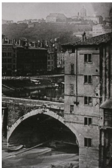
Le Pont de Pierre lors de la construction du nouveau pont, détail de l'élévation sud de l'immeuble, 1844-1845
