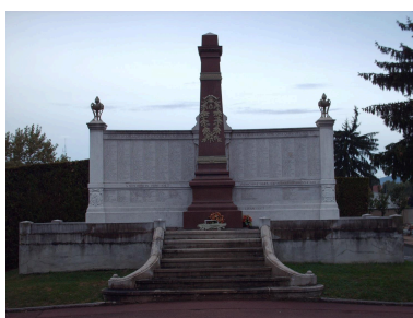
Vue générale en 2006 Phot. Véronique Belle IVR84_20216900590NUCA
