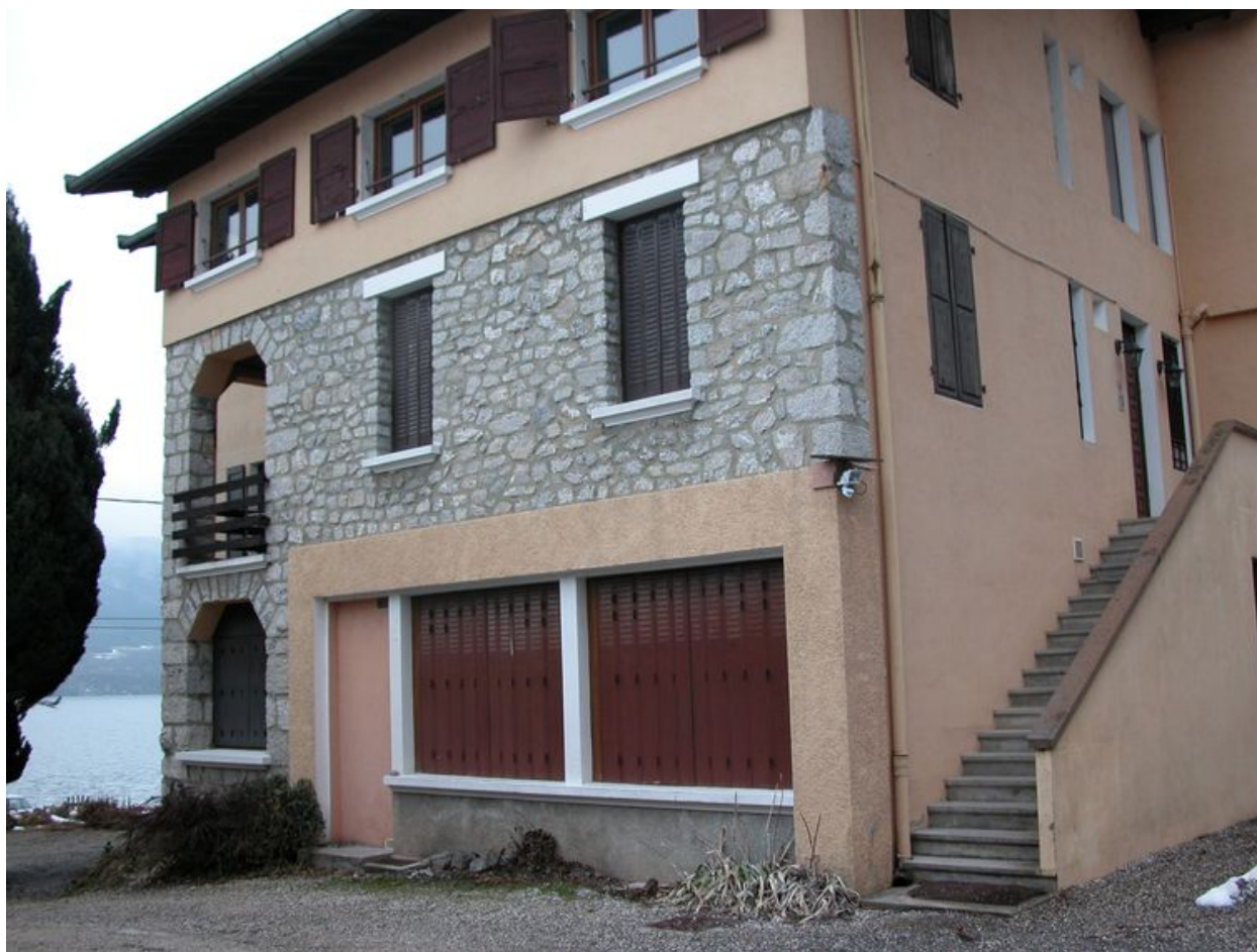
Vue de la façade sud.
