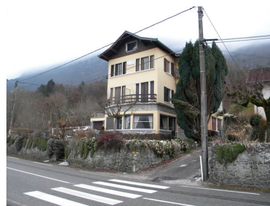
Vue d'ensemble avec bow- windows en avancée. Phot. Jérôme Daviet IVR82_20107402588NUCA
