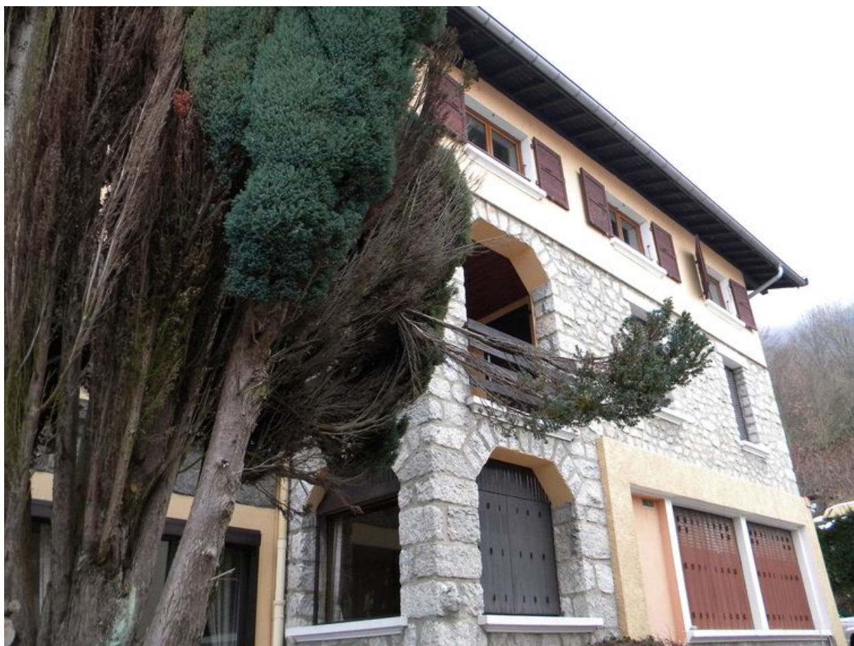
Détail du parement en pierre de taille.
