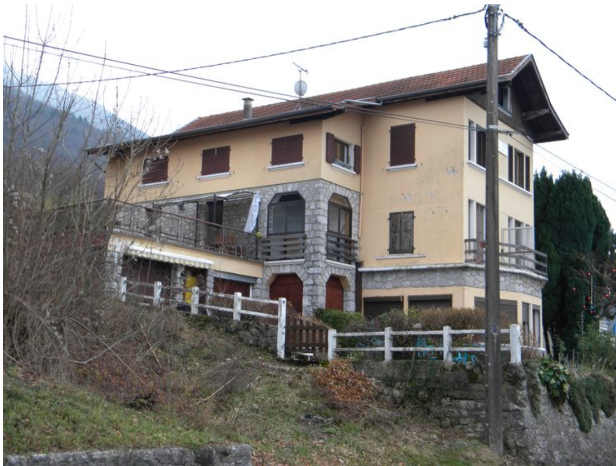
Vue de la façade nord.
