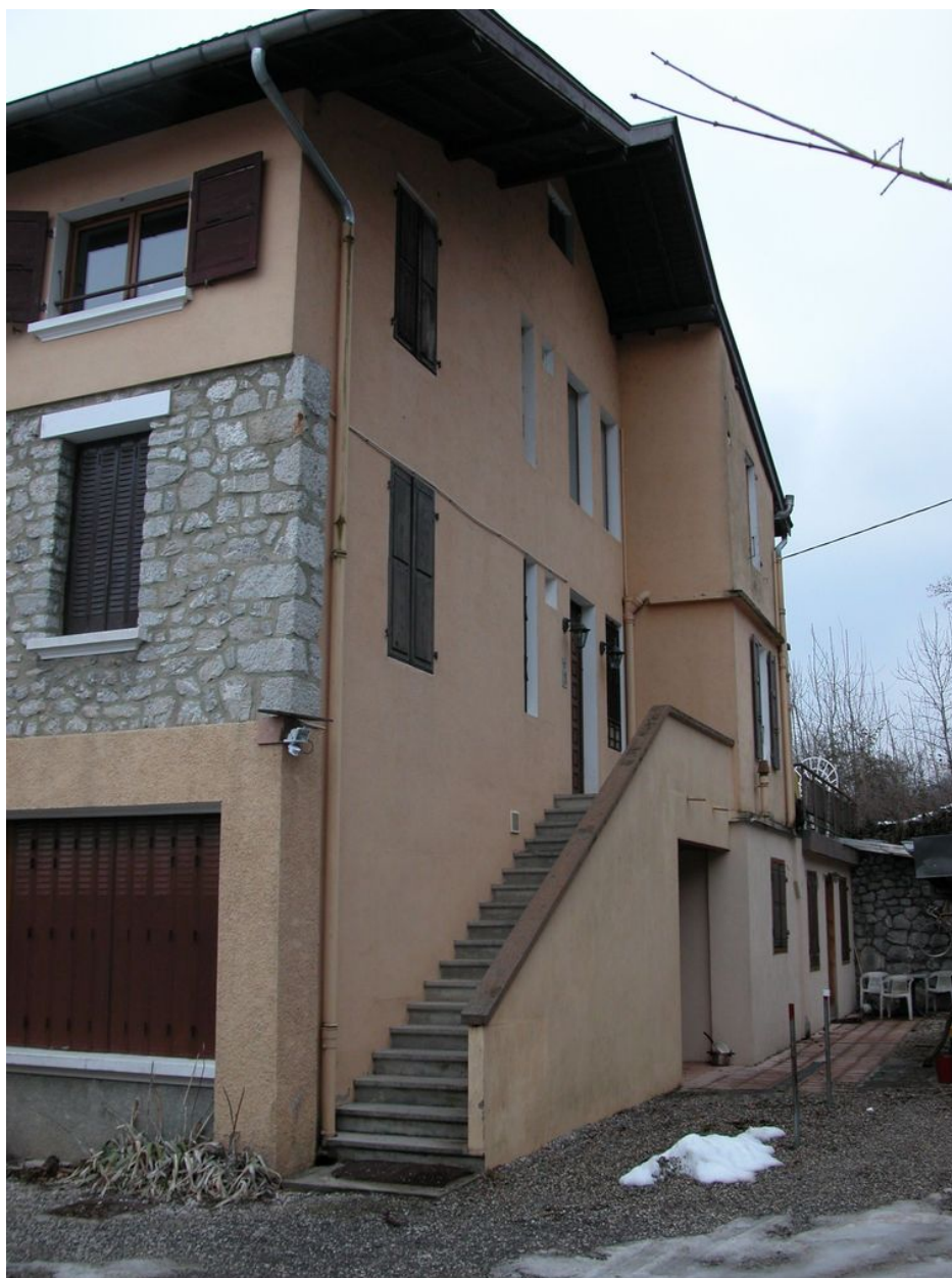
Vue de la façade arrière.
