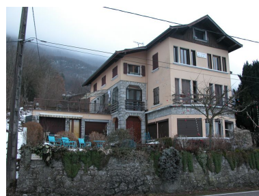
Vue de trois-quarts. Phot. Jérôme Daviet IVR82_20107402585NUCA
