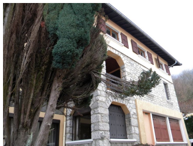
Détail du parement en pierre de taille.
