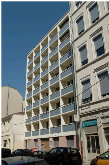
Vue générale. Phot. Catherine Guillot IVR82_20126902766NUCA
