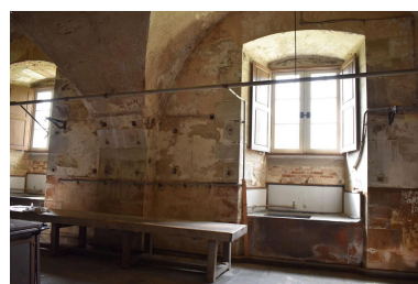
alimentation en eau chaude vers les éviers Phot. Maryse Durin-Tercelin IVR84_20226300617NUC4A
