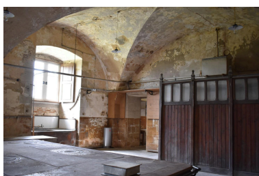
Vue du système d'alimentation en eau chaude Phot. Maryse Durin-Tercelin IVR84_20226300616NUC4A
