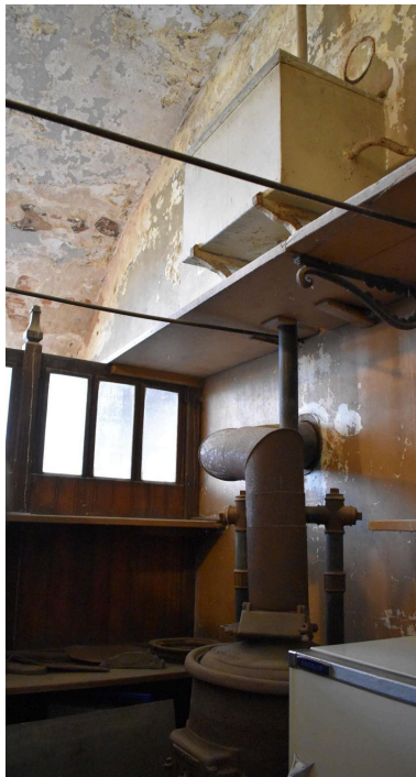
Vue de la réserve d'eau Phot. Maryse Durin-Tercelin IVR84_20226300613NUC4A
