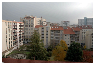
Elévation postérieure Phot. Maryannick Chalabi IVR82_20076900378NUCA
