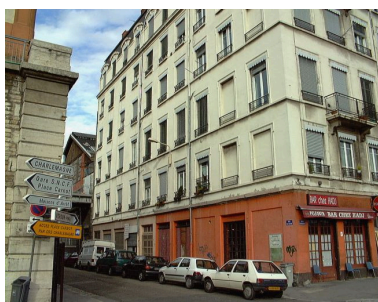
Vue de l'angle du quai Perrache et de la rue du Béliet, le rez-de-chaussée Phot. Bernard Ducouret IVR82_20006900647NUCA
