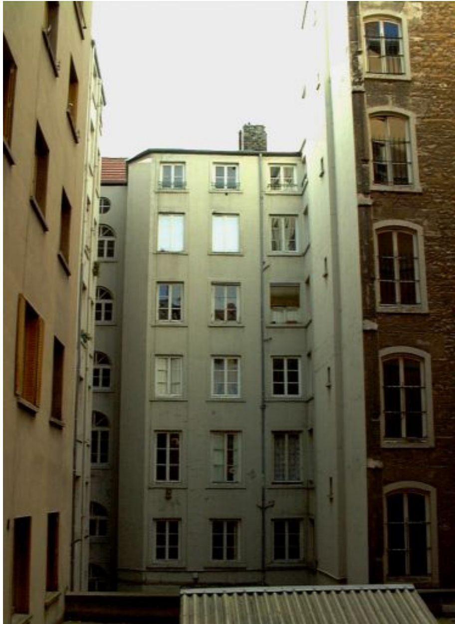
Elévation postérieure et travée d'escalier
