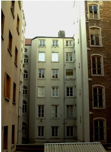
Elévation postérieure et travée d'escalier Phot. Bernard Ducouret IVR82_20006900649NUCA
