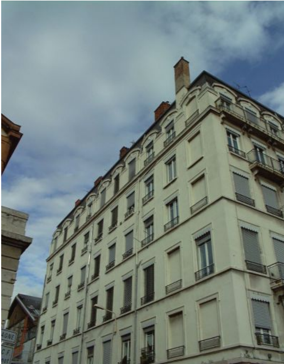
Vue de l'angle du quai Perrache et de la rue du Bélier, les étages
