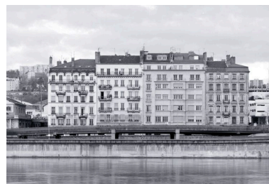
Vue d'ensemble depuis l'est Phot. Eric Dessert IVR82_20026903019X
