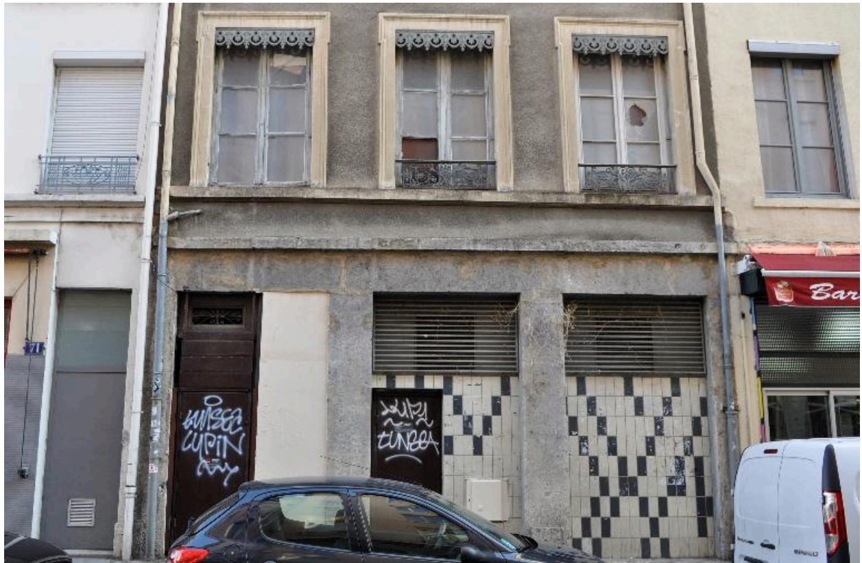
Boutiques et porte d'entrée condamnées
