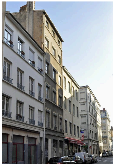
Vue d'ensemble Phot. Magali Delavenne IVR84_20166902188NUCA
