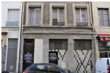
Boutiques et porte d'entrée condamnées Phot. Magali Delavenne IVR84_20166902189NUCA
