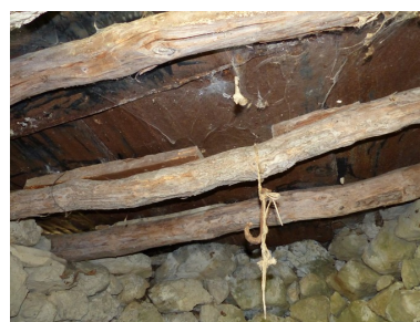
Couvrement : pannes et tôle. Phot. Alexeï Laurent IVR84_20162601150NUCA
