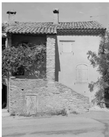
Élévation principale d'une maison (A3 540), située en haut du village, au principal carrefour. Phot. Alain Franchella IVR82_19972600446X
