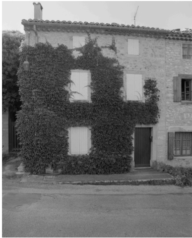
L'élévation principale d'une maison (D 163), portant la date 1830, du type le plus fréquent. Phot. Alain Franchella IVR82_19972600481X
