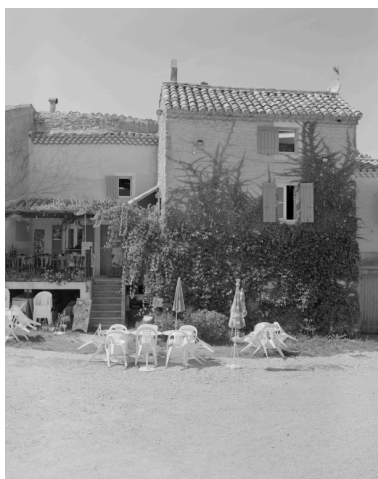
Vue de l'élévation principale d'une maison du haut du village (A3 534), comprenant autrefois une épicerie et aujourd'hui un café. Phot. Alain Franchella IVR82_19972600441X
