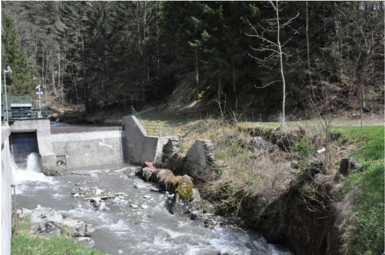
A droite, vestiges de la scierie Martinet. Au second plan, prise d'eau de la centrale de Feissons-sur-Isère.
