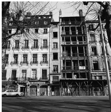
Façade sur le quai Phot. Jean-Marie Refflé IVR82_19796900043X
