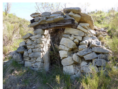
Vue d'ensemble prise du sud-ouest. Phot. Alexei Laurent IVR84_20162601235NUCA
