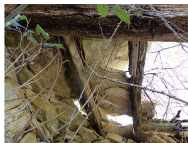
Couvrement : panne, chevrons et lauze. Phot. Alexei Laurent IVR84_20162601236NUCA
