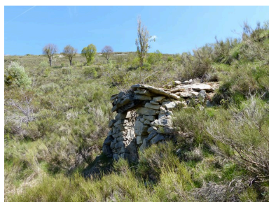
Vue d'ensemble prise du sud-ouest. Phot. Alexei Laurent IVR84_20162601234NUCA
