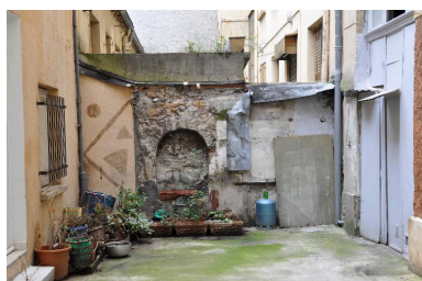
Cour, ancienne fontaine Phot. Magali Delavenne IVR84_20166900792NUCA
