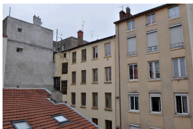
Elévation sur cour, vue partielle (à droite) Phot. Magali Delavenne IVR84_20166900791NUCA
