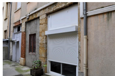
Elévation sur cour, ouvertures du rez-de-chaussée Phot. Magali Delavenne IVR84_20166900793NUCA
