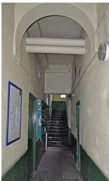
Vue intérieure : l'allée et l'escalier rampe-sur-rampe Phot. Magali Delavenne IVR84_20166900794NUCA
