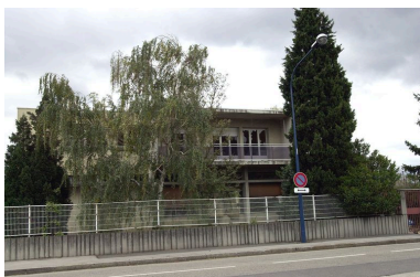
Corps des bureaux et logements, élévation antérieure Phot. Maryannick Chalabi
