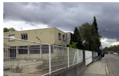
Corps des bureaux et logements, élévation latérale gauche Phot. Maryannick Chalabi
