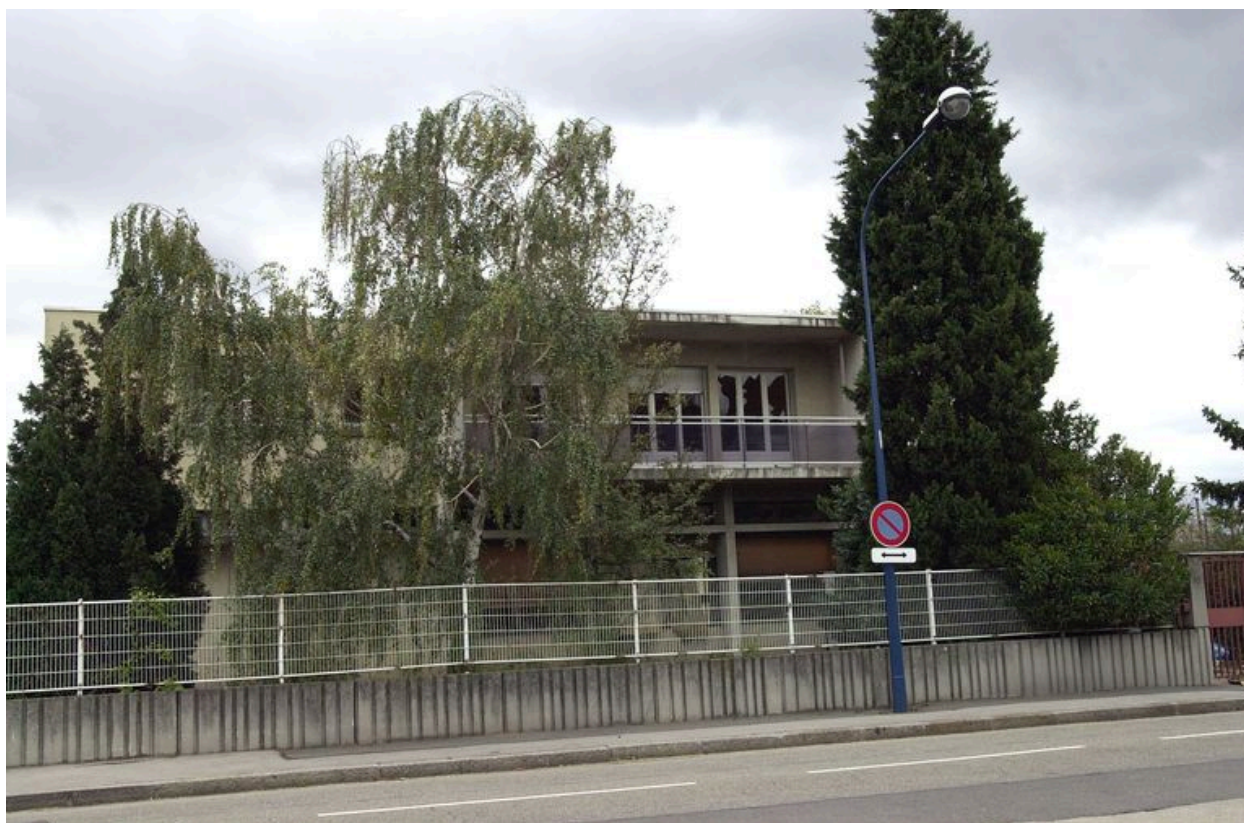
Corps des bureaux et logements, élévation antérieure
