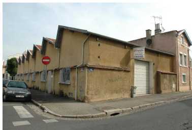
Vue des ateliers Phot. Nadine Halitim-Dubois IVR82_20146900160NUCA
