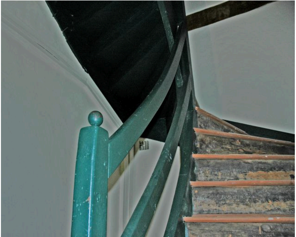
Volée de l'escalier en bois vue depuis l'angle nord-est
