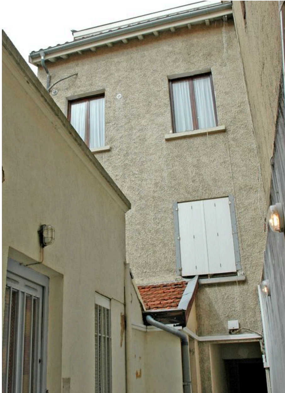
Façade ouest, vue depuis l'angle nord-ouest de la cour
