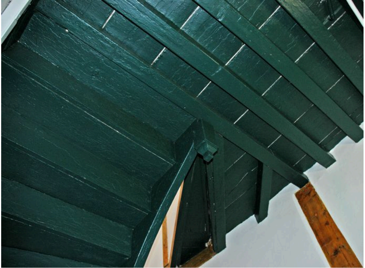
Aspect du palier en bois de l'étage surélevé vue d'en dessous
