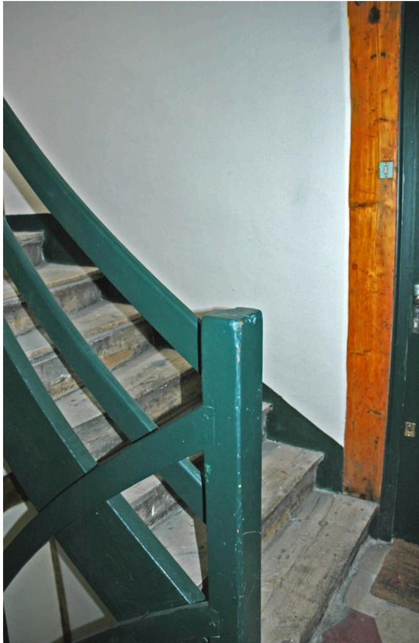
Départ de la seconde volée de l'escalier balancé en bois
