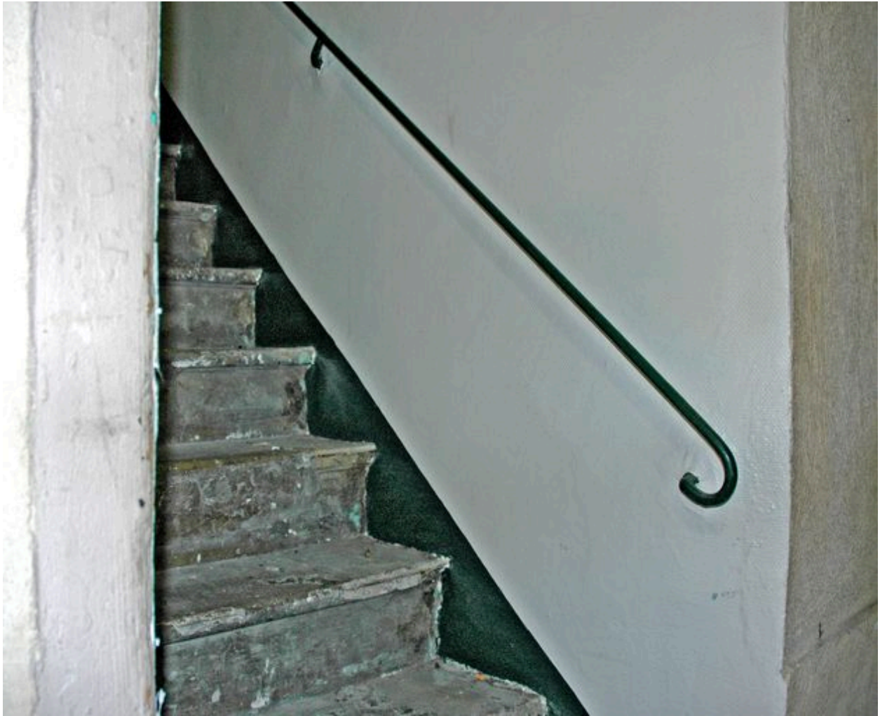
Départ de la première volée d'escalier depuis l'allée
