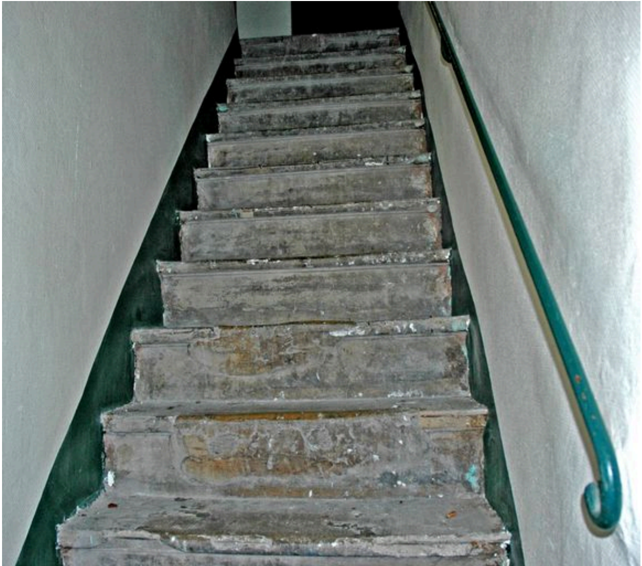
Première volée droite et en pierre de l'escalier vue depuis l'allée
