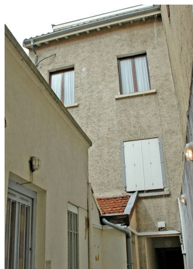
Façade ouest, vue depuis l'angle nord-ouest de la cour Phot. Maryannick Chalabi IVR82_20026901210NUCA
