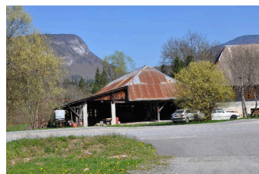
Vue actuelle de la scierie. Phot. Clara Bérelle IVR82_20137302705NUCA
