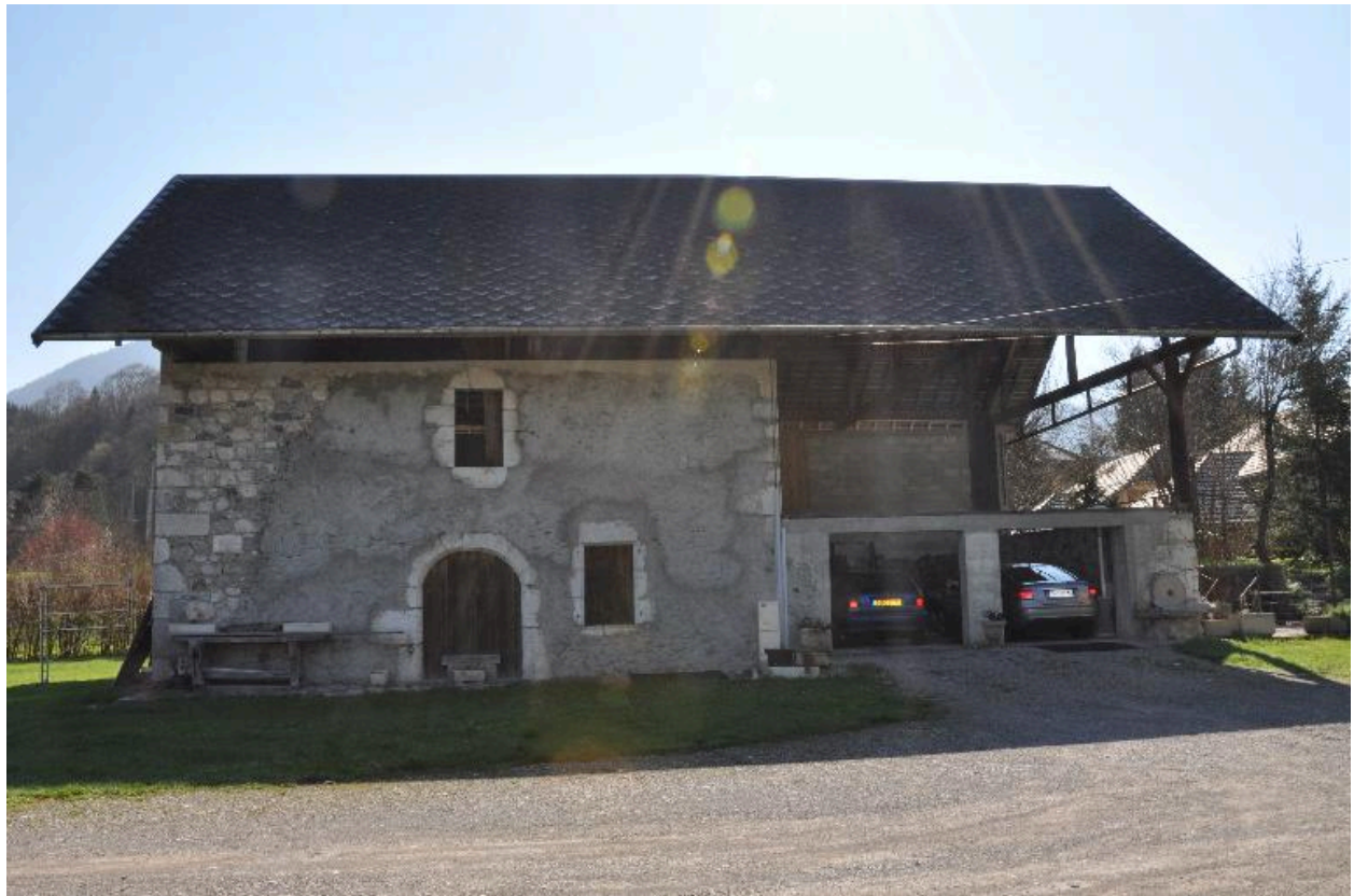
Vue du moulin amont.
