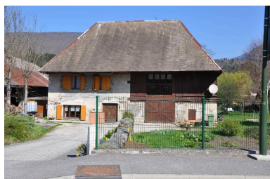
Vue du moulin aval. Phot. Clara Bérelle IVR82_20137302706NUCA
