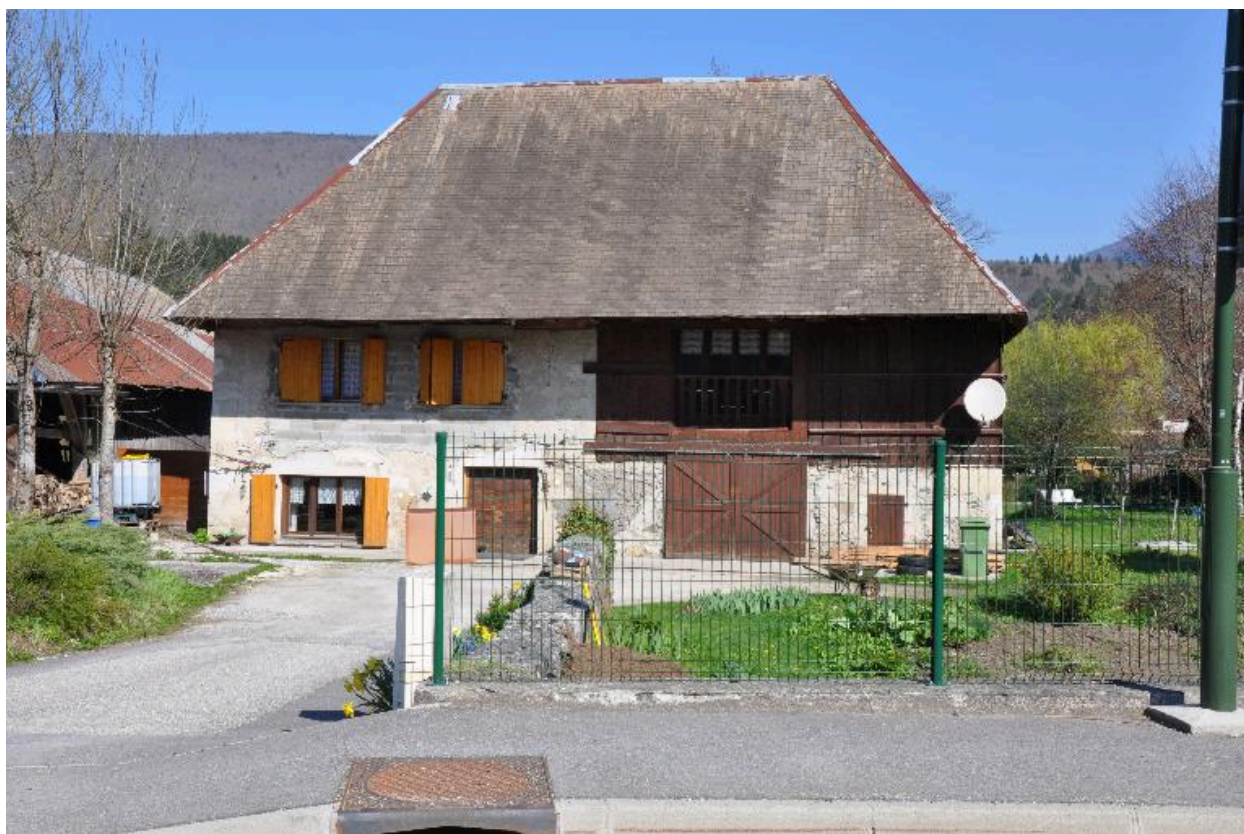
Vue du moulin aval.
