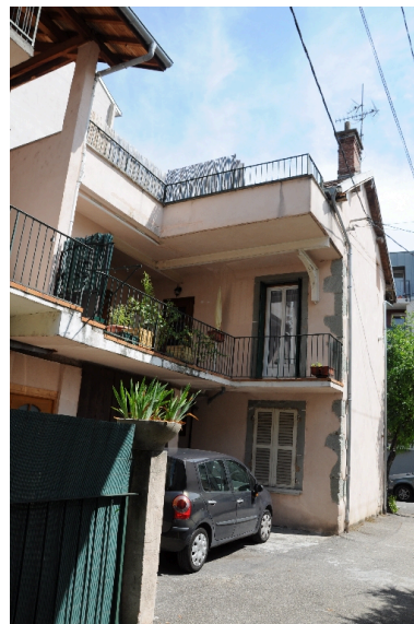
Élévation sur cour Phot. François Fouger IVR82_20127300166NUCA
