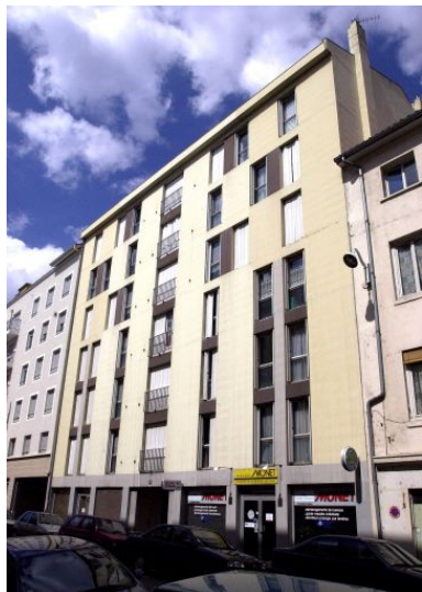
Elévation principale Phot. François Blanchetière IVR82_20016901959NUCA
