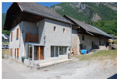
Vue générale. Phot. Thierry Monnet IVR84_20247300860NUCA
