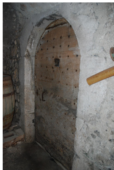
Porte de la cave de l'habitation médiane (2018 YC 128). Phot. Thierry Monnet IVR84_20247300863NUCA
