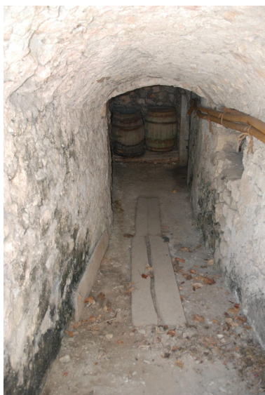
Couloir de la cave de l'habitation médiane (2018 YC 128). Phot. Thierry Monnet IVR84_20247300862NUCA
