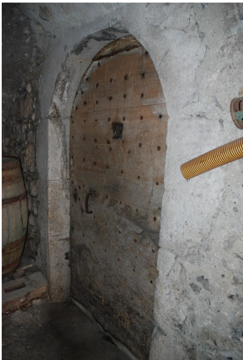
Porte de la cave de l'habitation médiane (2018 YC 128).
