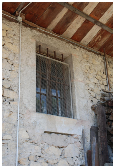
Fenêtre de l'habitation nord (2018 YC 127). Phot. Thierry Monnet IVR84_20247300864NUCA
