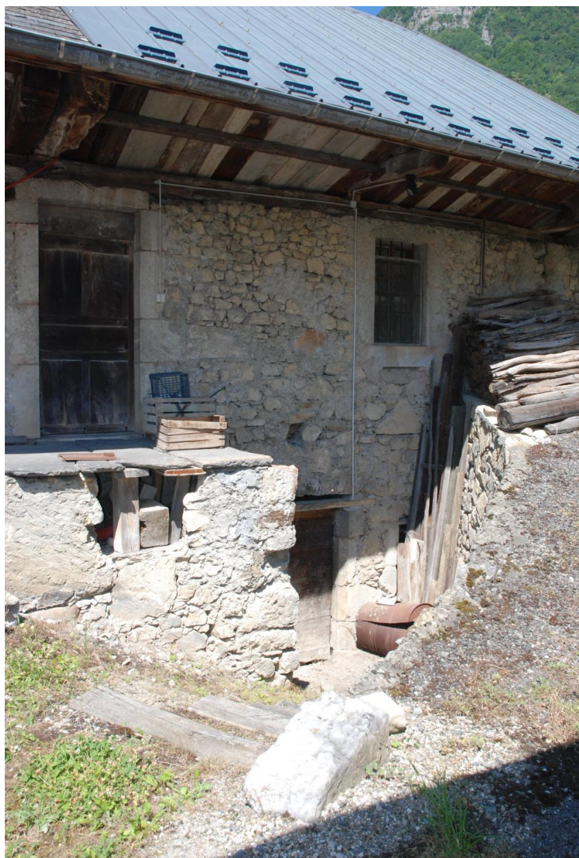
Vue de l'habitation nord (2018 YC 127).
