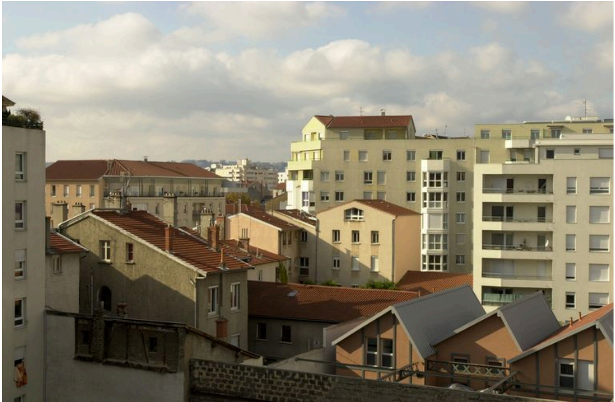
Vue d'ensemble du corps de bâtiment arrière depuis l'est
