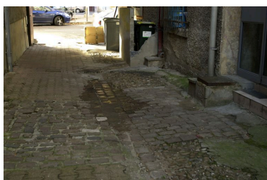
Le pavage de la cour commune Phot. Maryannick Chalabi IVR82_20086900707NUCA
