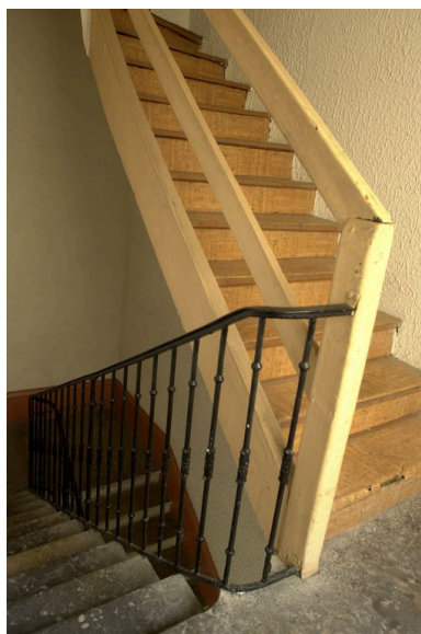
Vue de la dernière volée de l'escalier Phot. Maryannick Chalabi IVR82_20086900709NUCA
