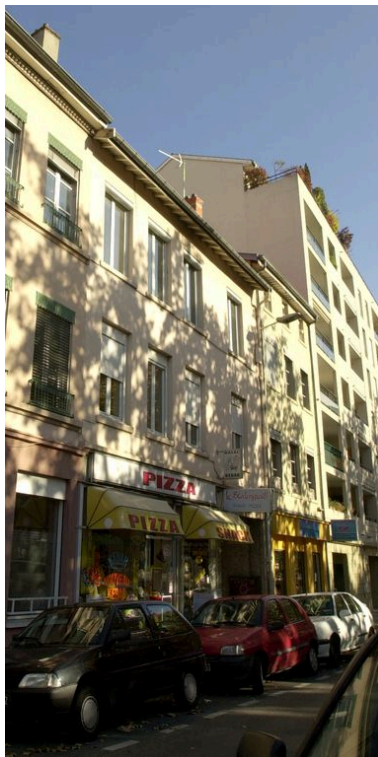
Élévation principale depuis le sud-ouest Phot. Maryannick Chalabi IVR82_20086900702NUCA
