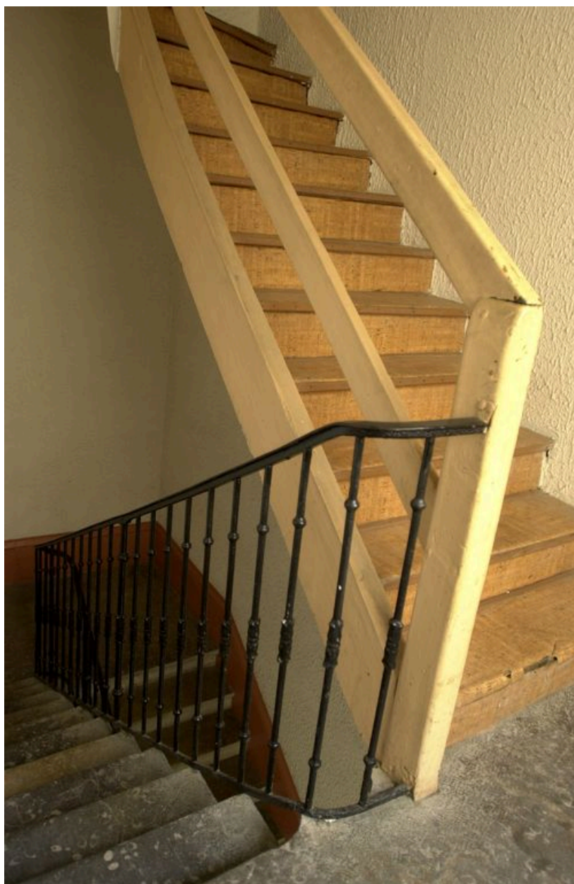
Vue de la dernière volée de l'escalier
