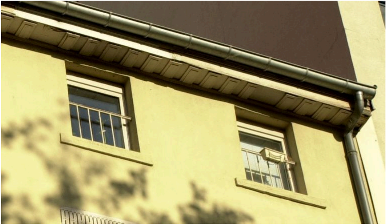
Détail de la corniche à modillons de l'élévation principale
