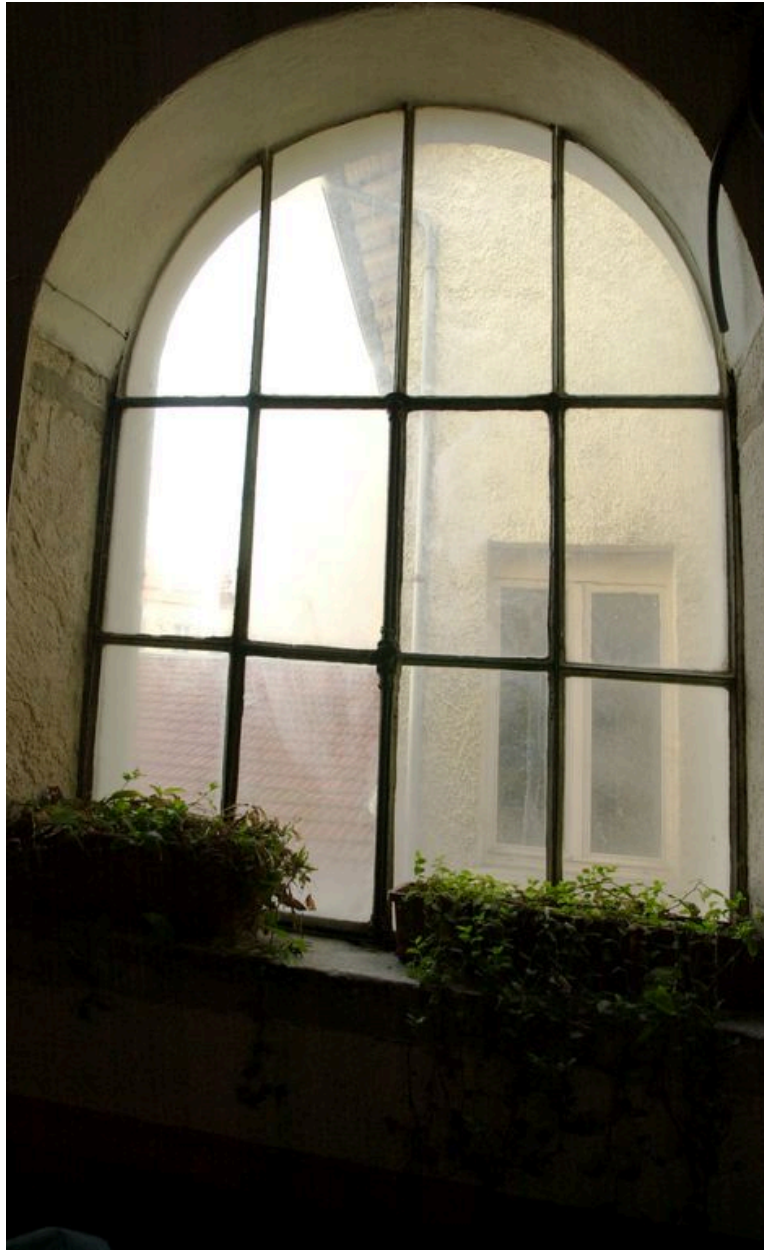
Vue d'une baie de la cage d'escalier
