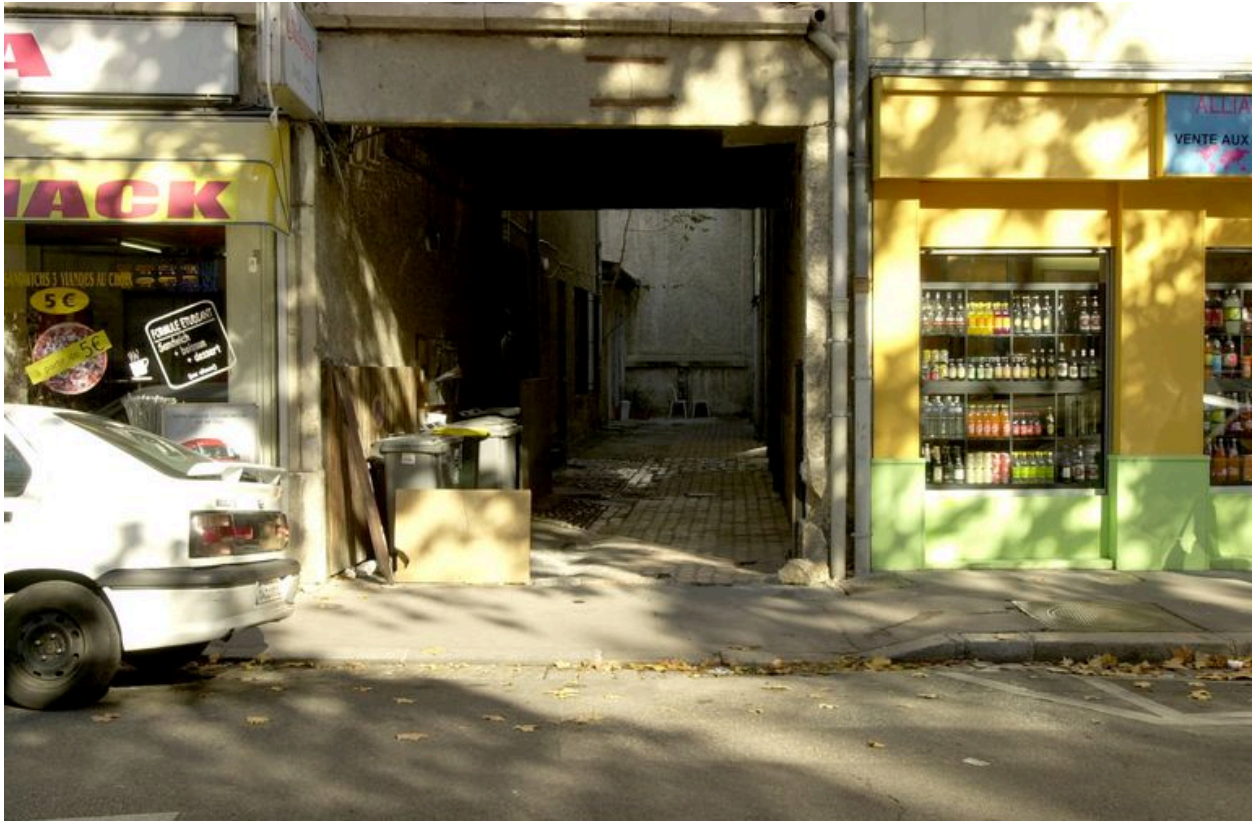
Entrée du passage couvert
