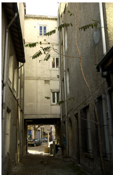
Vue de l'élévation postérieure du corps de passage Phot. Maryannick Chalabi IVR82_20086900705NUCA
