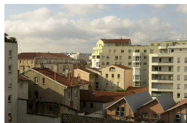
Vue d'ensemble du corps de bâtiment arrière depuis l'est Phot. Maryannick Chalabi IVR82_20086900674NUCA
