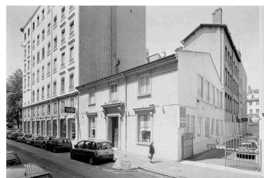
Succursale de la société Coignet rue Rabelais 3e arrondissement Phot. Didier Gourbin IVR82_20056900183P
