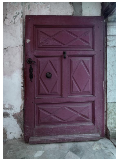
Détail : vantail de la porte d'entrée. Phot. Eric Dessert IVR84_20177401032NUCAQ
