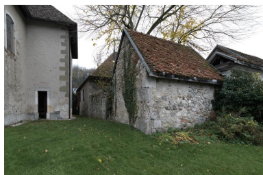
Vue depuis le nord : clôture, passage entre le presbytère et l'église.
