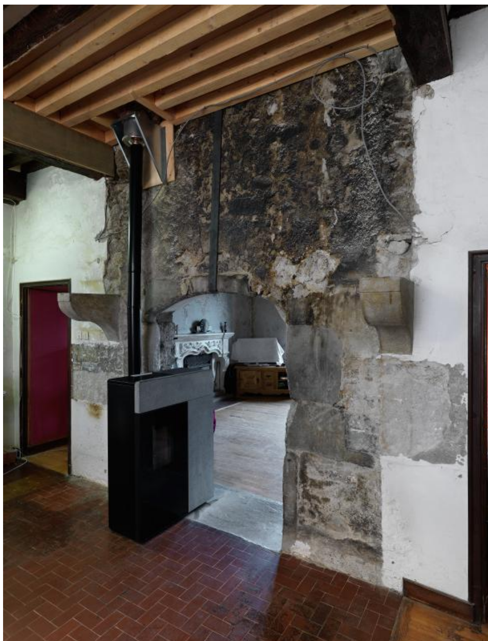
Vue intérieure : cheminée du 1er étage.
