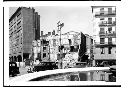
Vue de l'immeuble en cours de démolition, 1937. fotogr. Nég. sur verre AM Lyon. 3 Ph 00237 Phot. Jacques Gastineau IVR82_20066901483NUC
