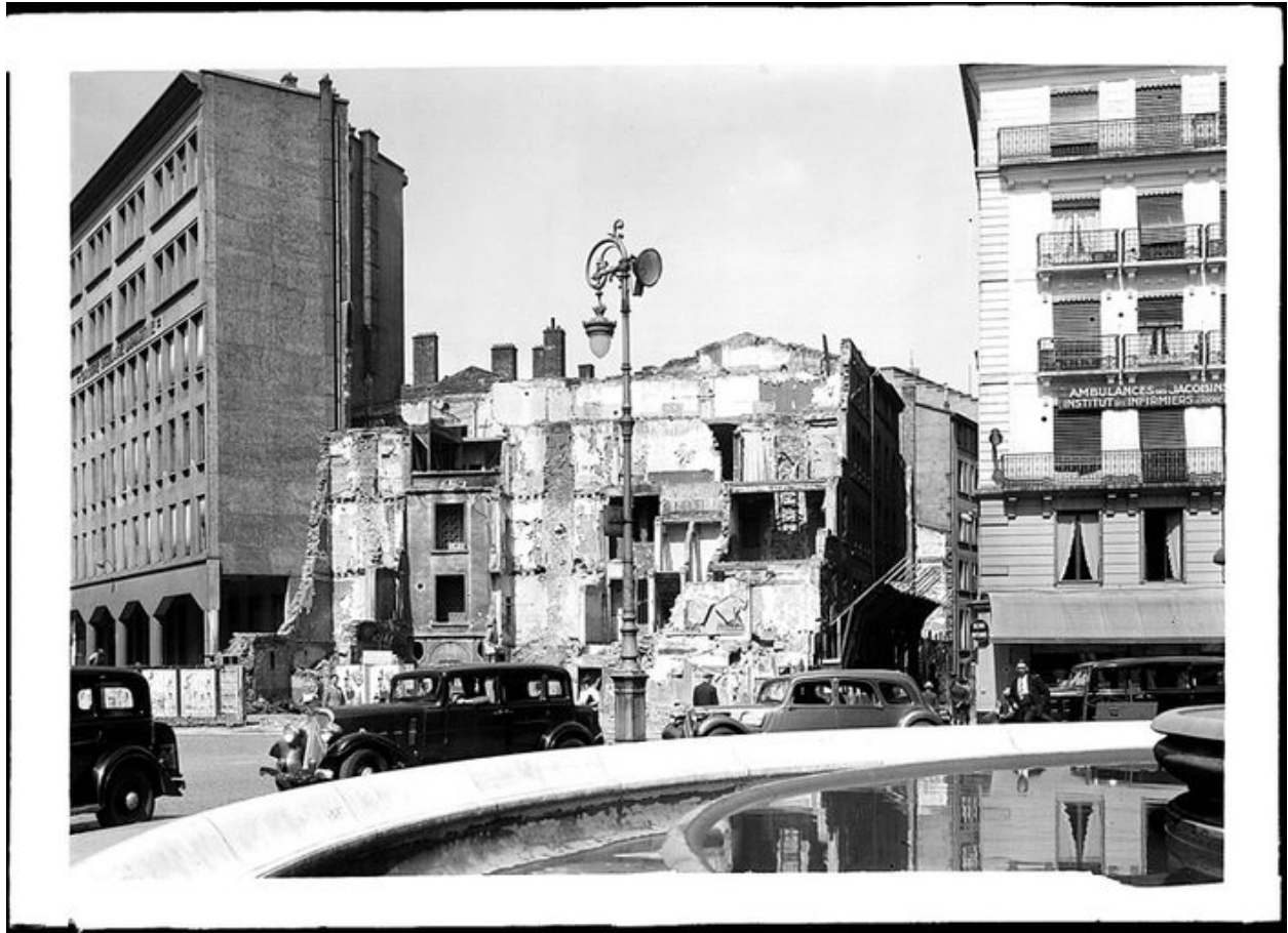
Vue de l'immeuble en cours de démolition, 1937. fotogr. Nég. sur verre AM Lyon. 3 Ph 00237
