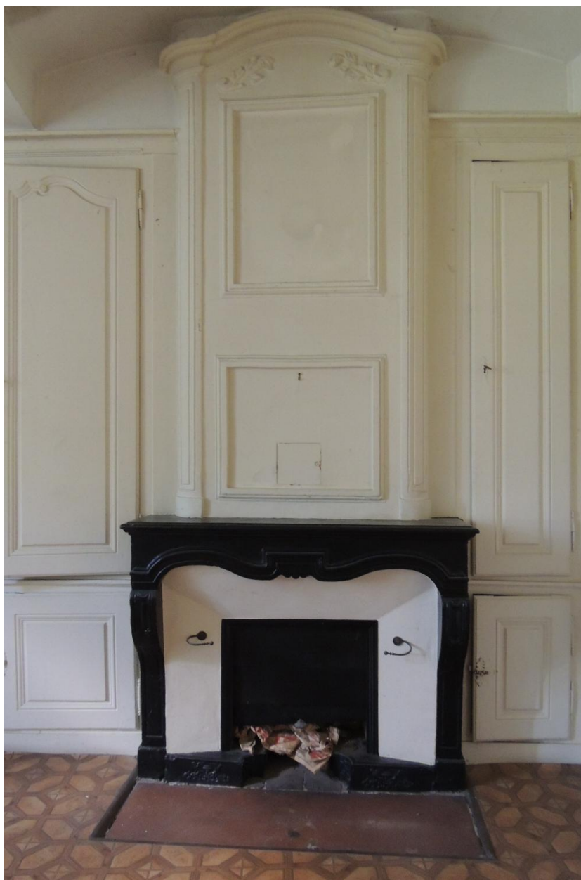
Palier, salle des archives : cheminée à trumeau.
