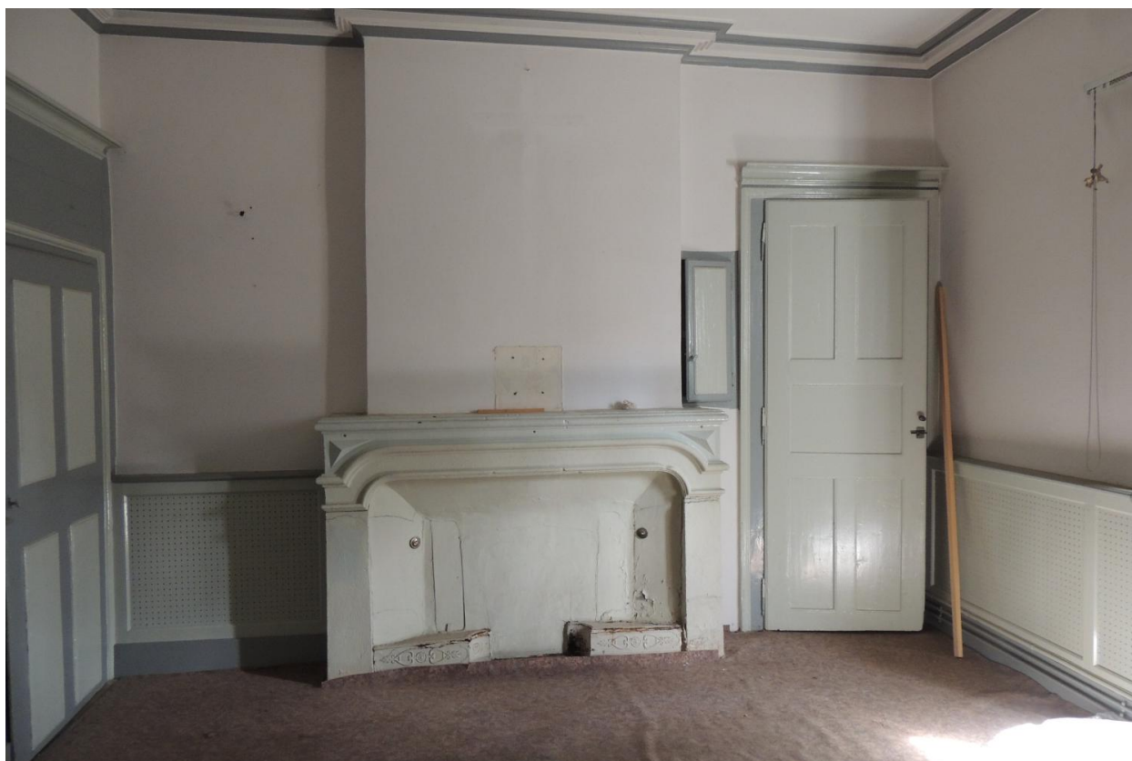
Rez-de-chaussée, salle : cheminée.
