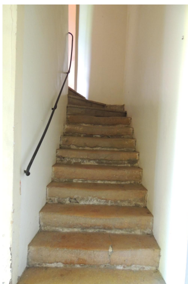
Escalier d'accès à l'étage. Phot. Elisabeth Dandel IVR84_20210100227NUCA
