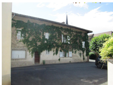
Vue d'ensemble, façade est. Phot. Elisabeth Dandel IVR84_20200100419NUCA
