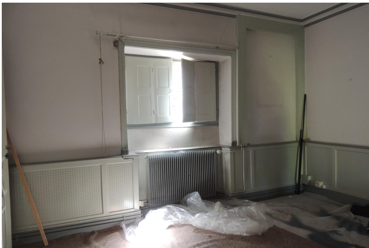
Rez-de-chaussée, salle : baie avec volets intérieurs.
