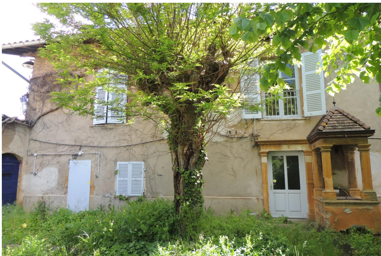
Façade sur jardin, partie nord-ouest.
