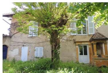
Façade sur jardin, partie nord-ouest. Phot. Elisabeth Dandel IVR84_20210100219NUCA
