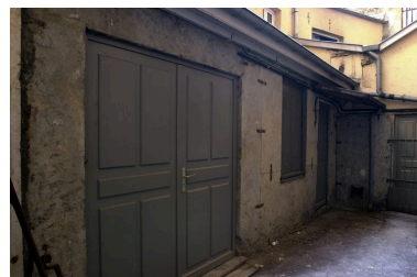
La cour Phot. Véronique Belle IVR82_20076901299NUCA
