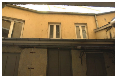
La cour : élévations des communs Phot. Véronique Belle IVR82_20076902904NUCA
