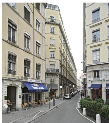
Vue de situation depuis le quai des Célestins Phot. Eric Dessert IVR82_20076902486NUCA
