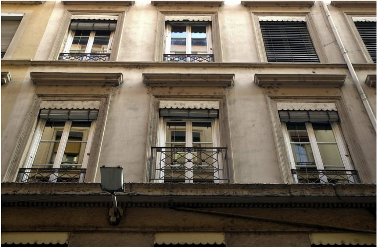
L'élévation antérieure : détail des étages carrés
