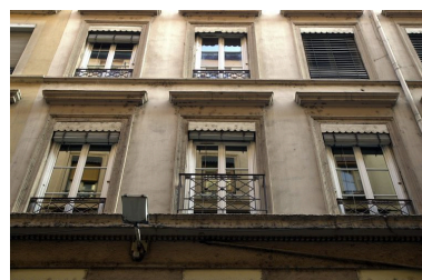
L'élévation antérieure : détail des étages carrés Phot. Véronique Belle IVR82_20076902926NUCA
