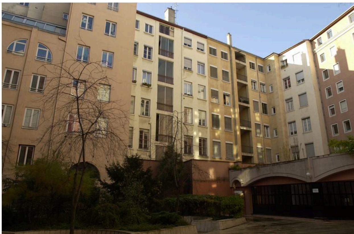
A droite, l'élévation sur cour
