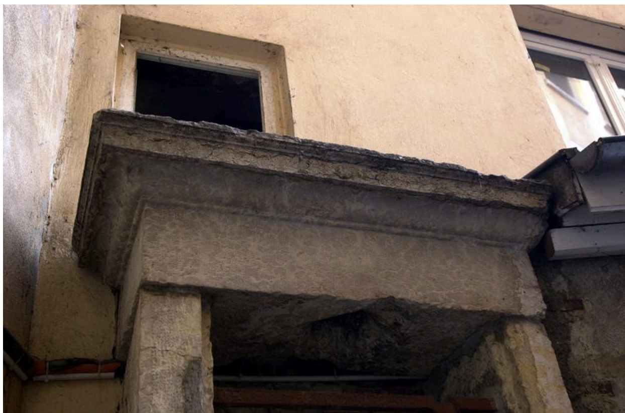
La cour : puits, détail
