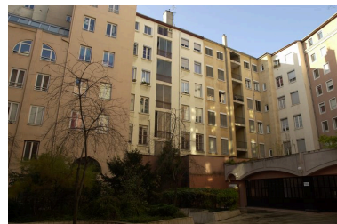
A droite, l'élévation sur cour Phot. Véronique Belle IVR82_20076901253NUCA
