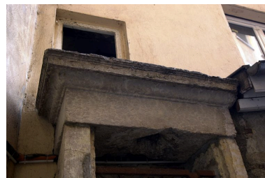
La cour : puits, détail Phot. Véronique Belle IVR82_20076902901NUCA
