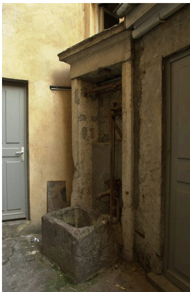
La cour : ancien puits, fontaine et son bassin Phot. Véronique Belle IVR82_20076901300NUCA
