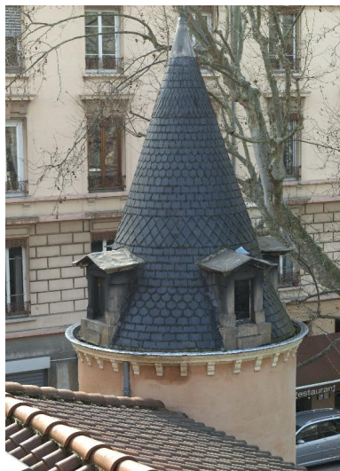
Détail de la tourelle d'angle.
