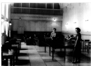
Détail de l'ancienne chapelle (vue vers le nord) dans les années 1960 ? (CROUS Lyon Saint-Etienne, photographie).
