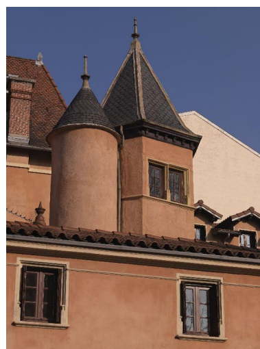
Détail des tourelles, depuis l'ouest.
