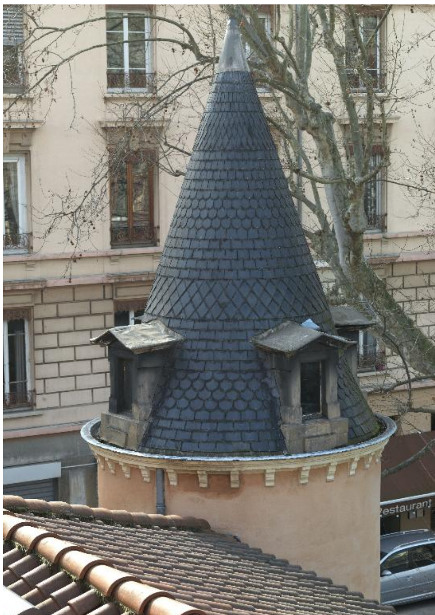
Détail de la tourelle d'angle.
