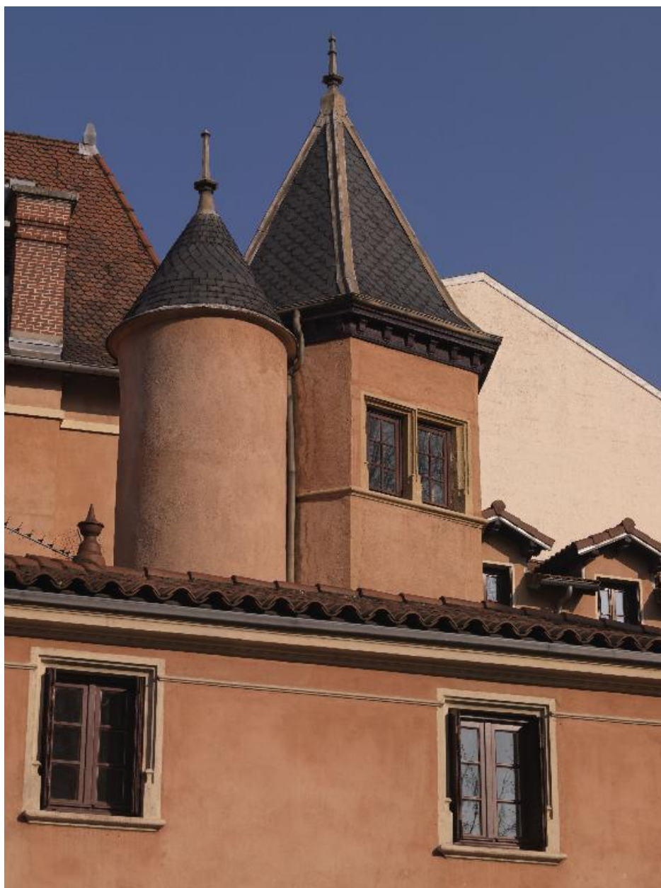
Détail des tourelles, depuis l'ouest.
