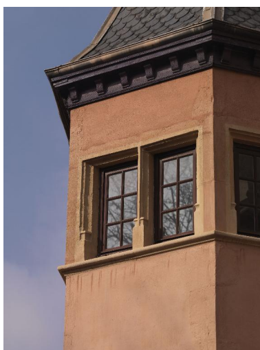
Détail des ouvertures de la tour polygonale.
