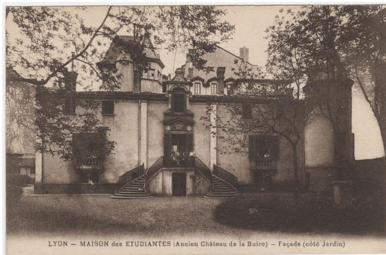
Vue de l'élévation ouest, sur le jardin (côté rue Garibaldi), vers 1920 (Arch. mun. Lyon, carte postale, 4FI_11403).
