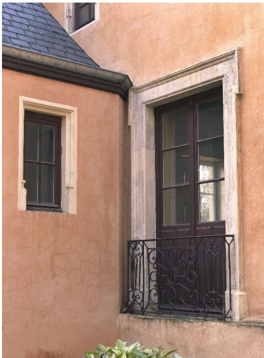
L'ancienne maison forte : détail de l'élévation sud.
