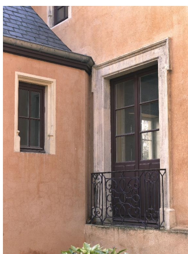
L'ancienne maison forte : détail de l'élévation sud.
