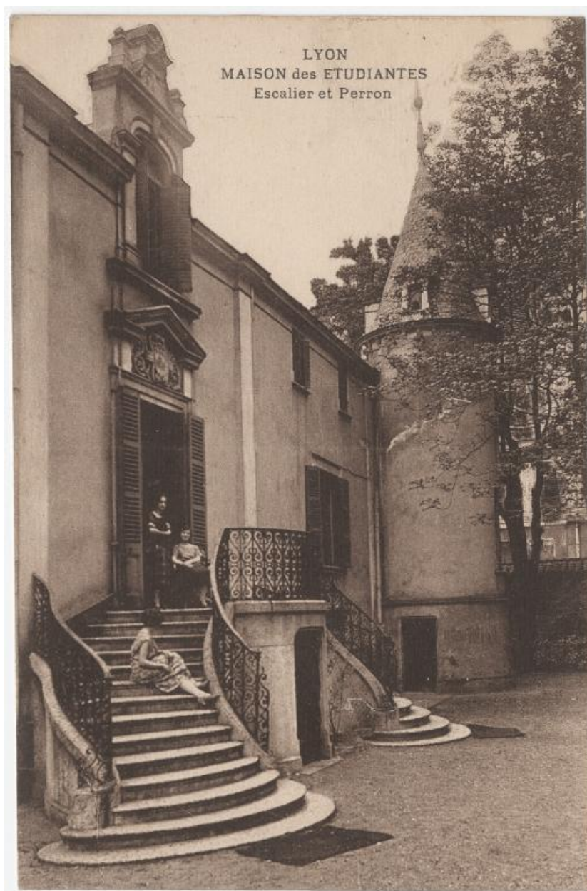
Vue de l'élévation ouest, sur le jardin (côté rue Garibaldi), vers 1920-1930 (Arch. mun. Lyon, carte postale, 4FI_11405).
