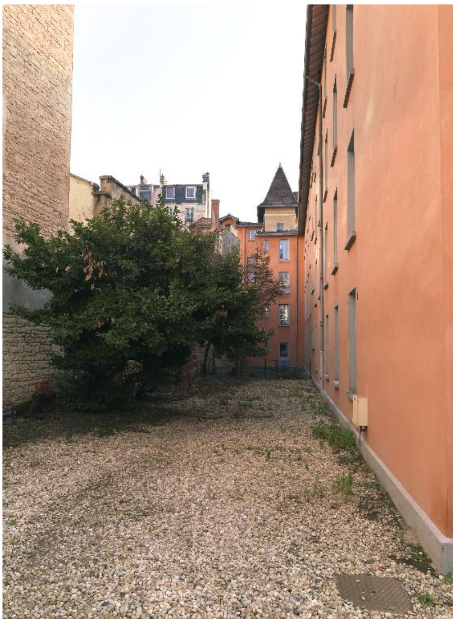
Vue de l'élévation ouest des dortoirs.
