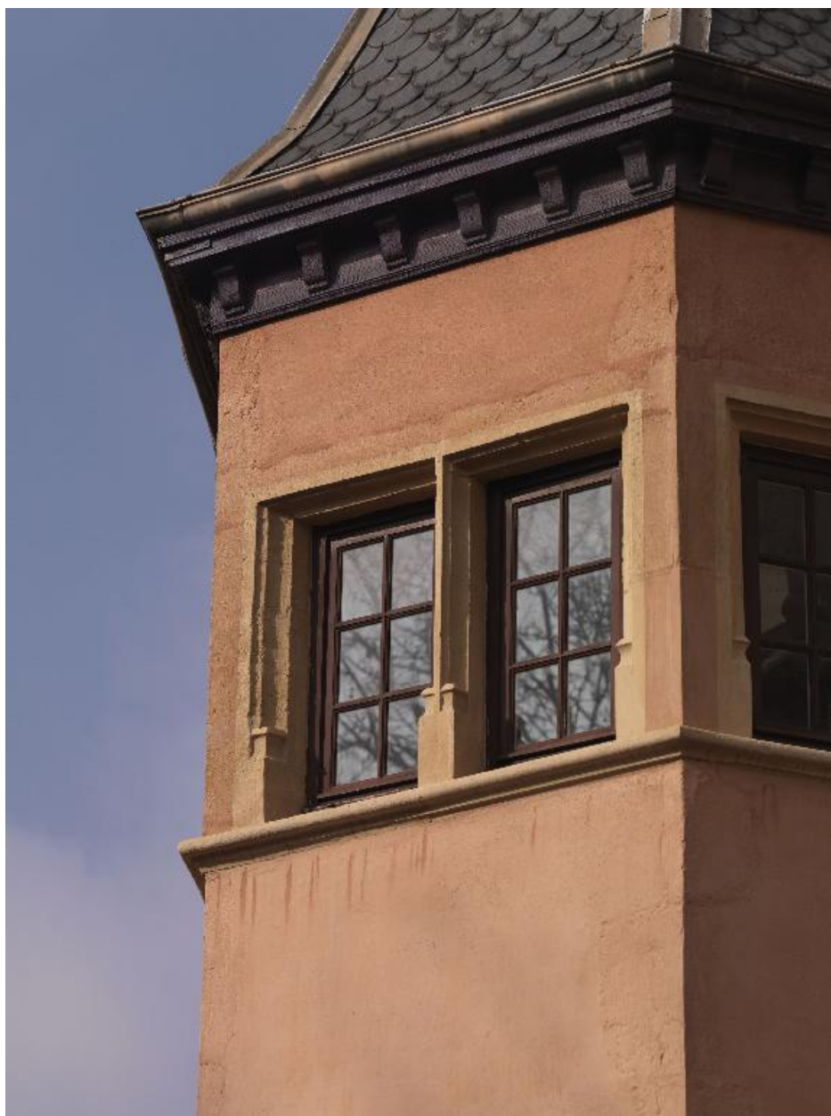
Détail des ouvertures de la tour polygonale.
