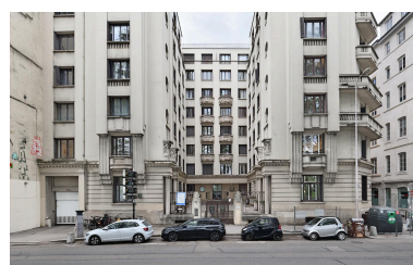
Façade principale de l'immeuble des soieries Rosset Phot. Thierry Leroy IVR84_20266900175NUCAQ
