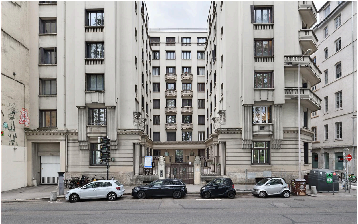
Façade principale de l'immeuble des soieries Rosset
