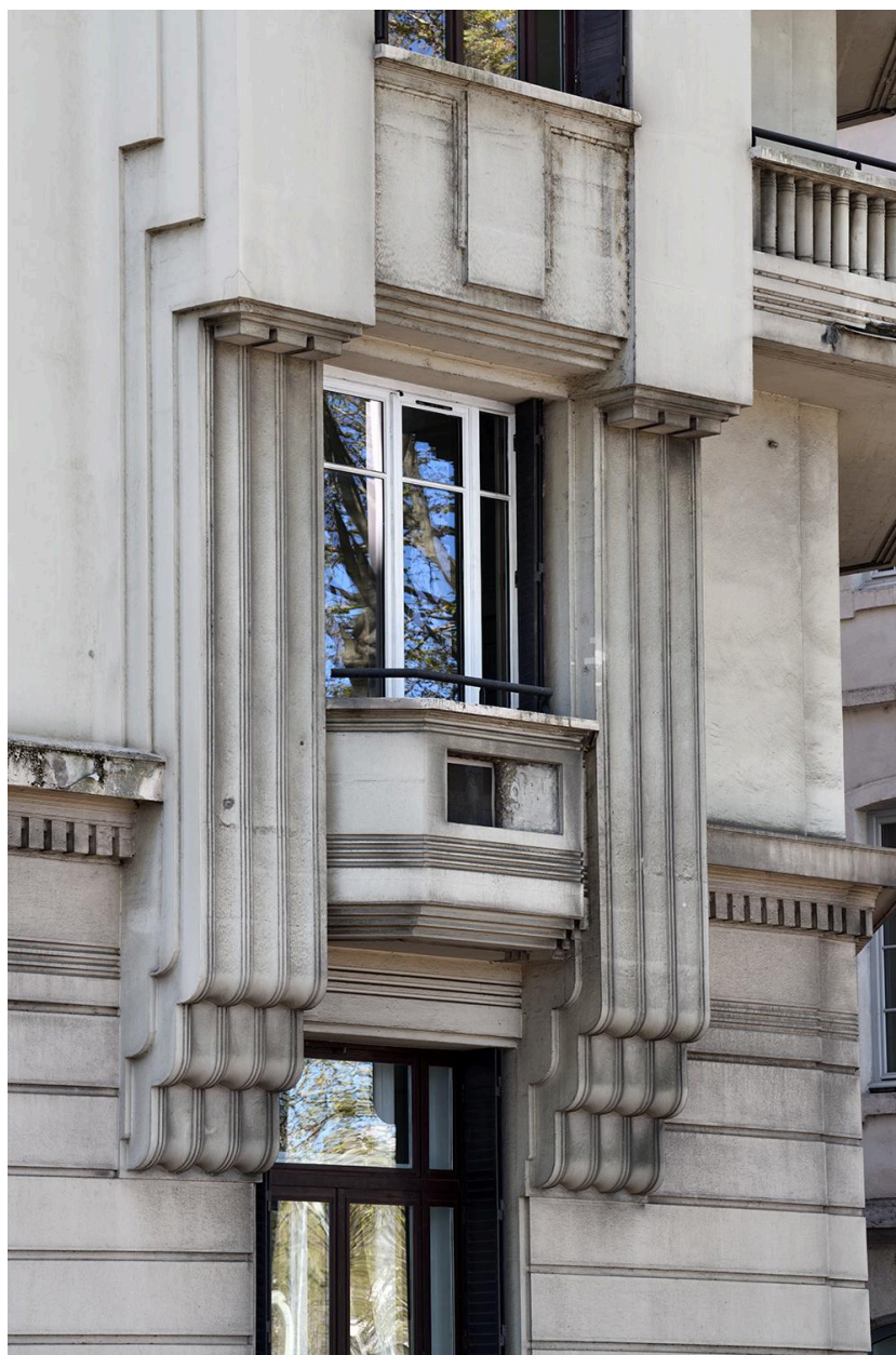
Bureaux des soieries Rosset : détail façade
