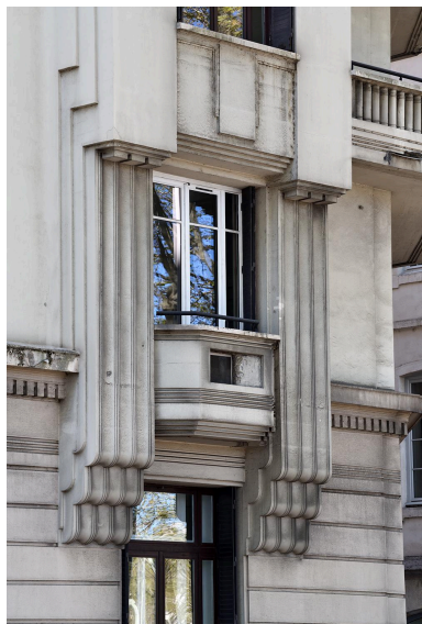
Bureaux des soieries Rosset : détail façade Phot. Thierry Leroy IVR84_20266900186NUCAQ
