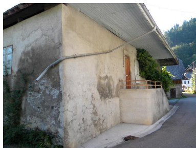
Vue de trois quarts d'une ferme transformée (2008 D4 894) Phot. Jérôme Daviet IVR82_20137401026NUCA
