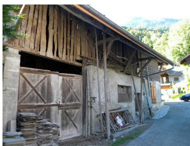
Façade d'une grange (2008 D4 868, 4026). Phot. Jérôme Daviet IVR82_20137401050NUCA
