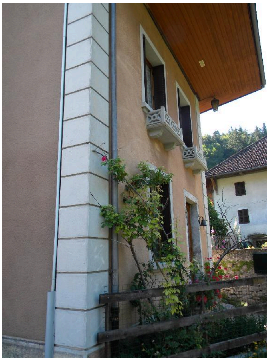
détail d'un chaînage droit (2008 D4 822).
