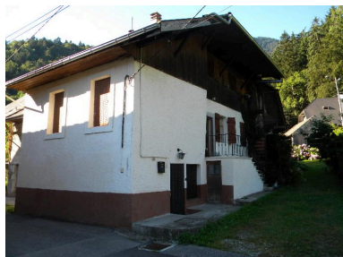
Vue d'une ferme en équerre modifiée (2008 D4 884, 885, 886). Phot. Jérôme Daviet IVR82_20137401038NUCA
