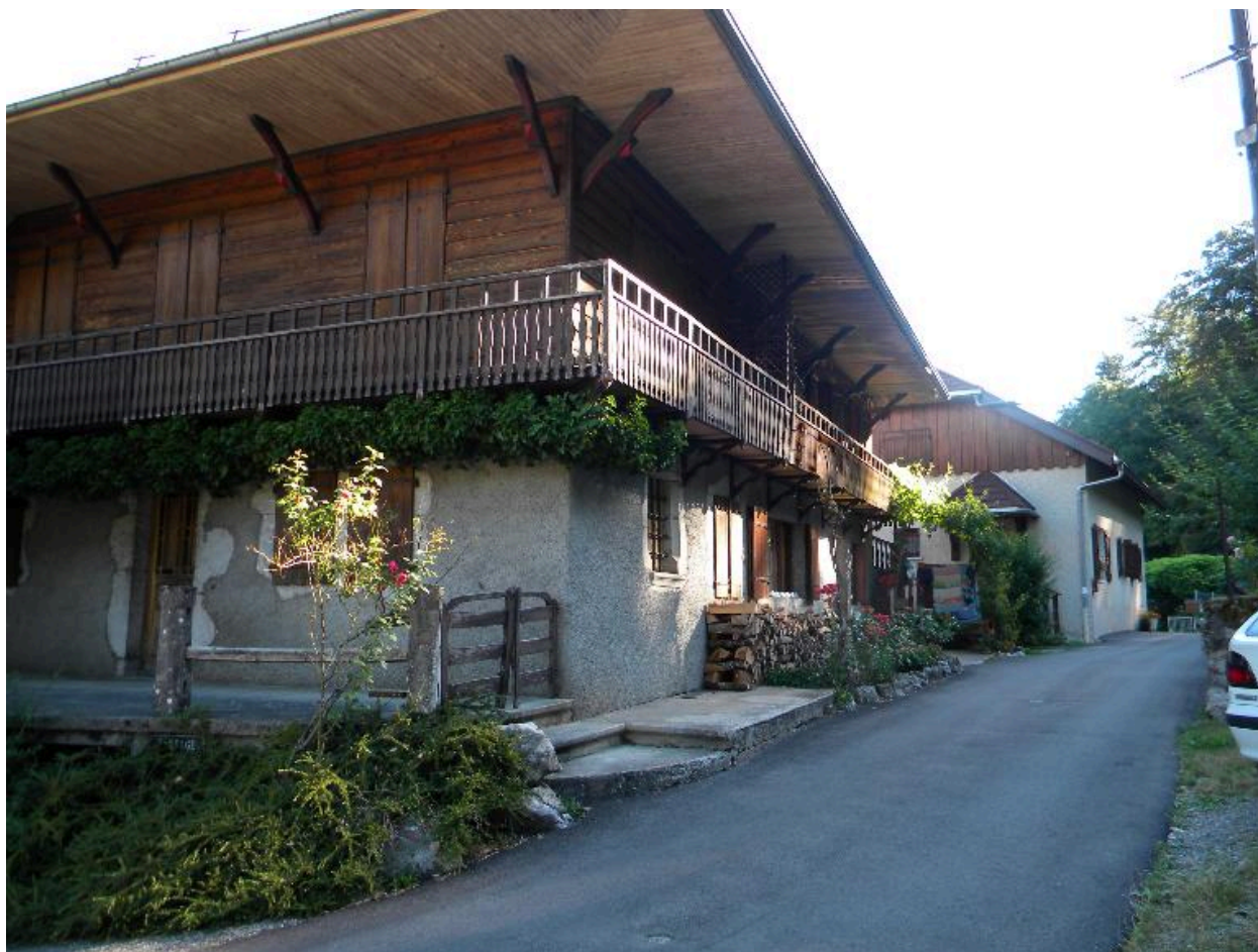
Vue d'ensemble d'une ancienne ferme (2008 D4 2737, 2738).
