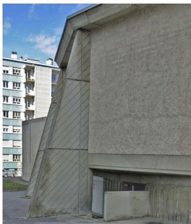
Détail des contreforts du chevet Phot. Maryannick Chalabi IVR82_20066900652NUCA
