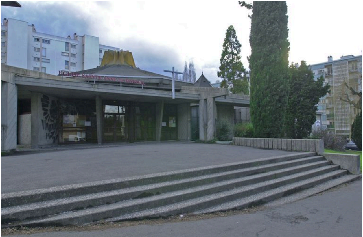
Vue du parvis depuis le nord-ouest
