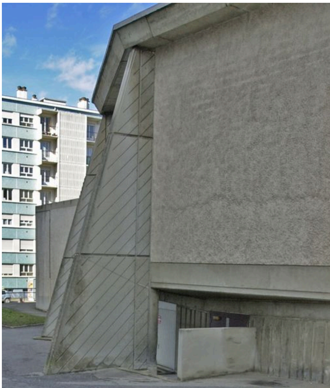
Détail des contreforts du chevet
