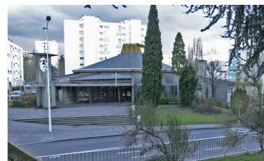
Vue générale depuis le nord Phot. Maryannick Chalabi IVR82_20066900689NUCA
