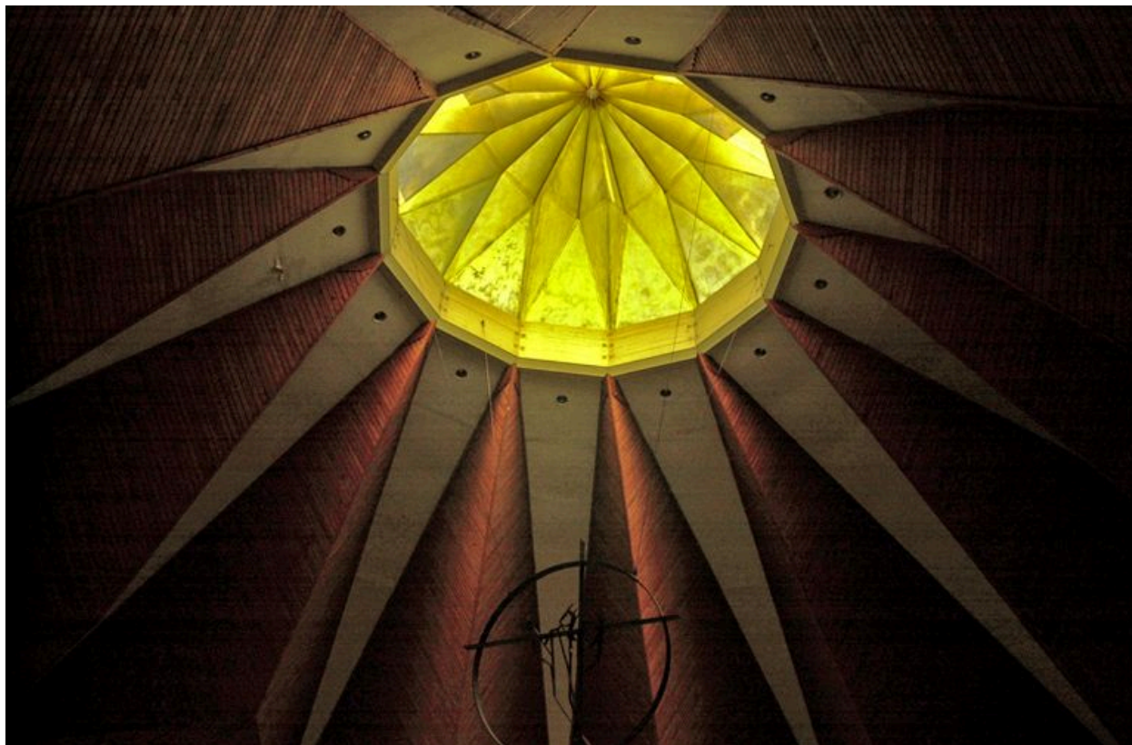
Détail du lanternon
