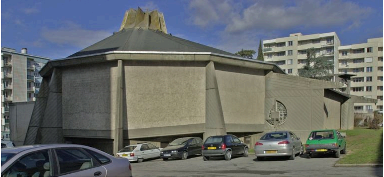
Vue du chevet depuis le sud-est
