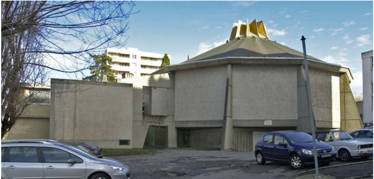
Vue du chevet de l'église depuis le sud-ouest
