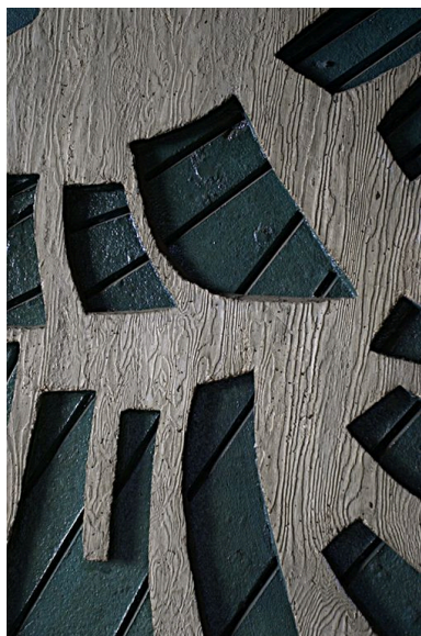
Détail du bas-relief du narthex Phot. Maryannick Chalabi IVR82_20066900671NUCA
