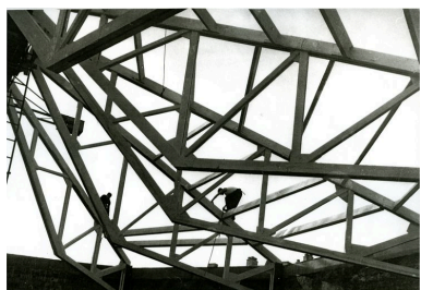
Vue de la charpente lors de la construction, depuis le dessous. Photogr. Paul Curtelin (Arch. privées) Phot. Maryannick Chalabi, Phot. Paul Curtelin IVR82_20066900734NUCA
