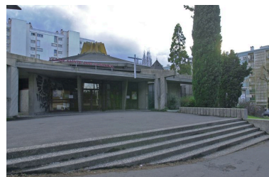
Vue du parvis depuis le nord-ouest Phot. Maryannick Chalabi IVR82_20066900682NUCA
