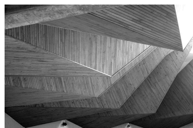
Détail du couvrement au- dessus des côtés de l'entrée Phot. Maryannick Chalabi IVR82_20066900674NUC
