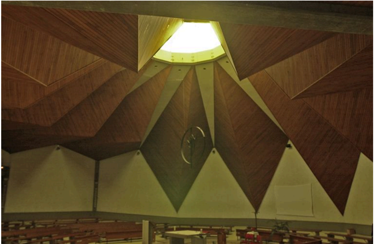
Vue générale du couvrement
