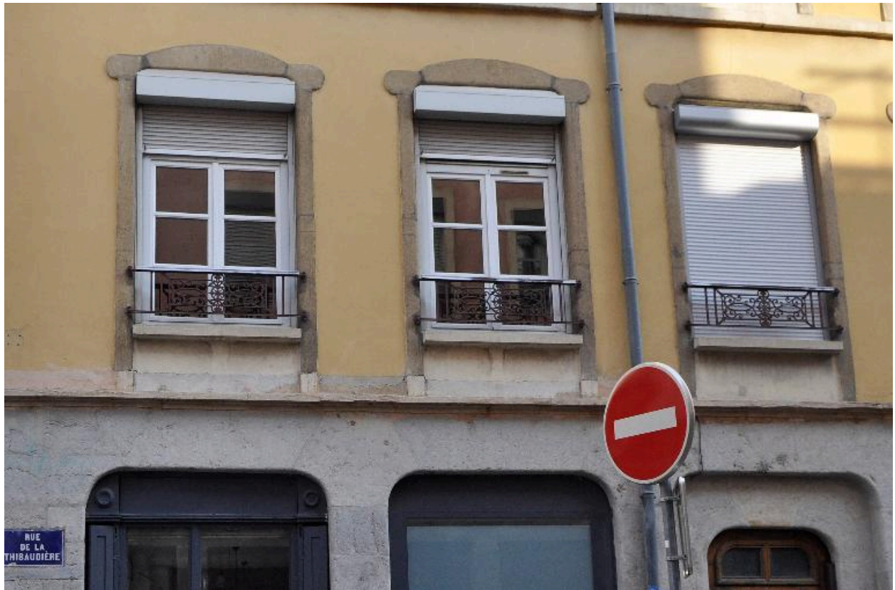
Élévation sur la rue Thibaudière, encadrements de baies
