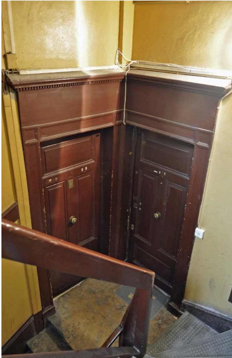
Vue intérieure : portes palières, menuiseries à fronton et corniche
