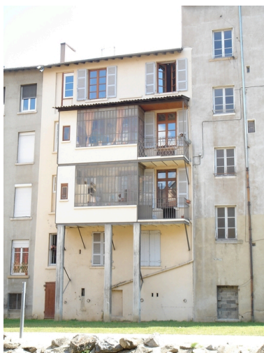
Façade sur Gère Phot. Isabelle Dupuis IVR82_20093800714NUCA
