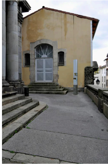
Parvis de l'église et corps de bâtiment ouest bâtiment du collège, depuis le nord Phot. Catherine Guégan IVR84_20194300028NUCA
