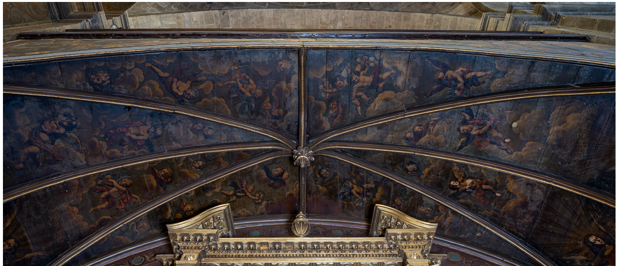
Chapelle de la Vierge : détail du décor de la voûte
