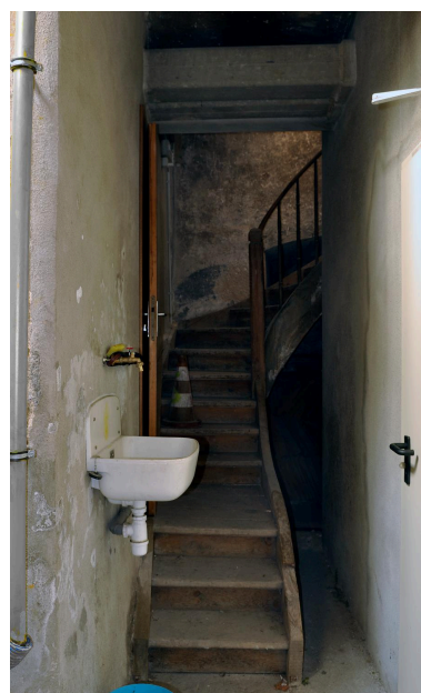
Ancienne sacristie, actuellement chaufferie : escalier montant à la tribune nord-est Phot. Catherine Guégan IVR84_20254300247NUCA
