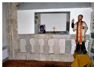
Galerie B, 1er niveau, salle 1 ; ancienne baie à balustre donnant sur la cour du collège, murée Phot. Catherine Guégan IVR84_20194300109NUCA
