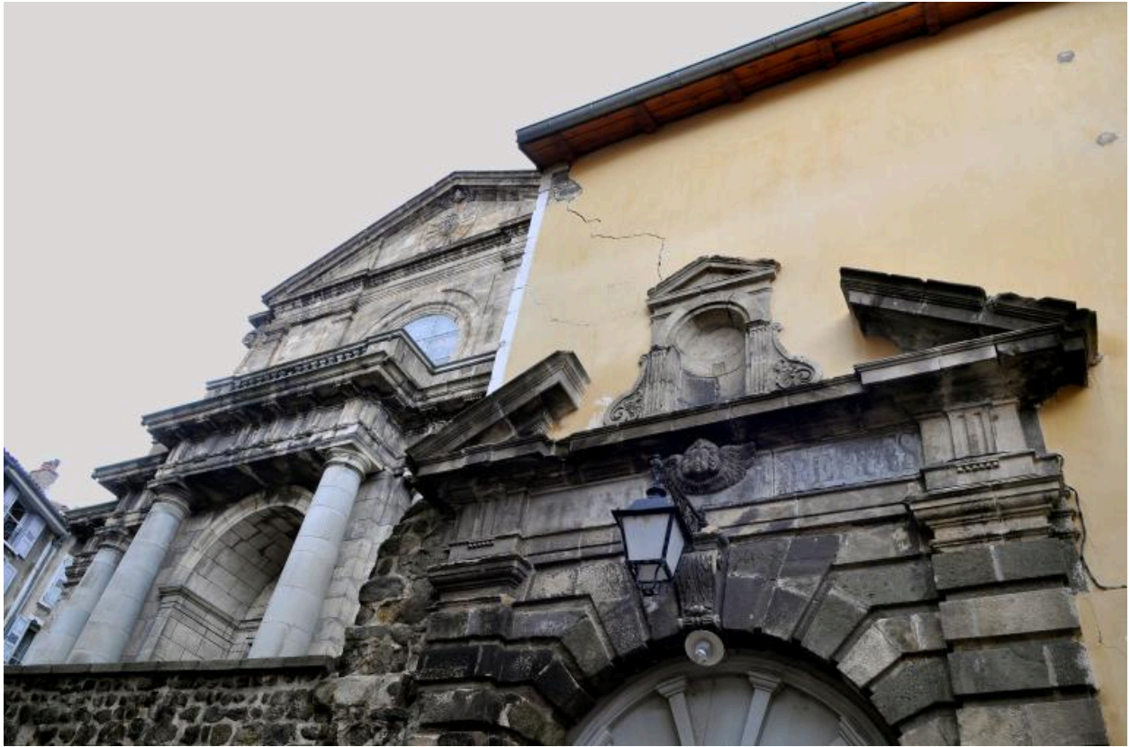
Façade de l'église vue depuis l'entrée du collège
