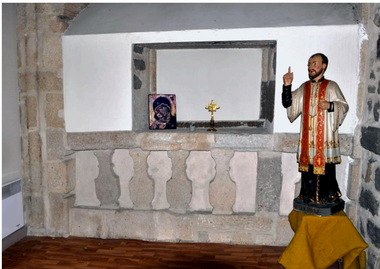
Galerie B, 1er niveau, salle 1 ; ancienne baie à balustre donnant sur la cour du collège, murée
