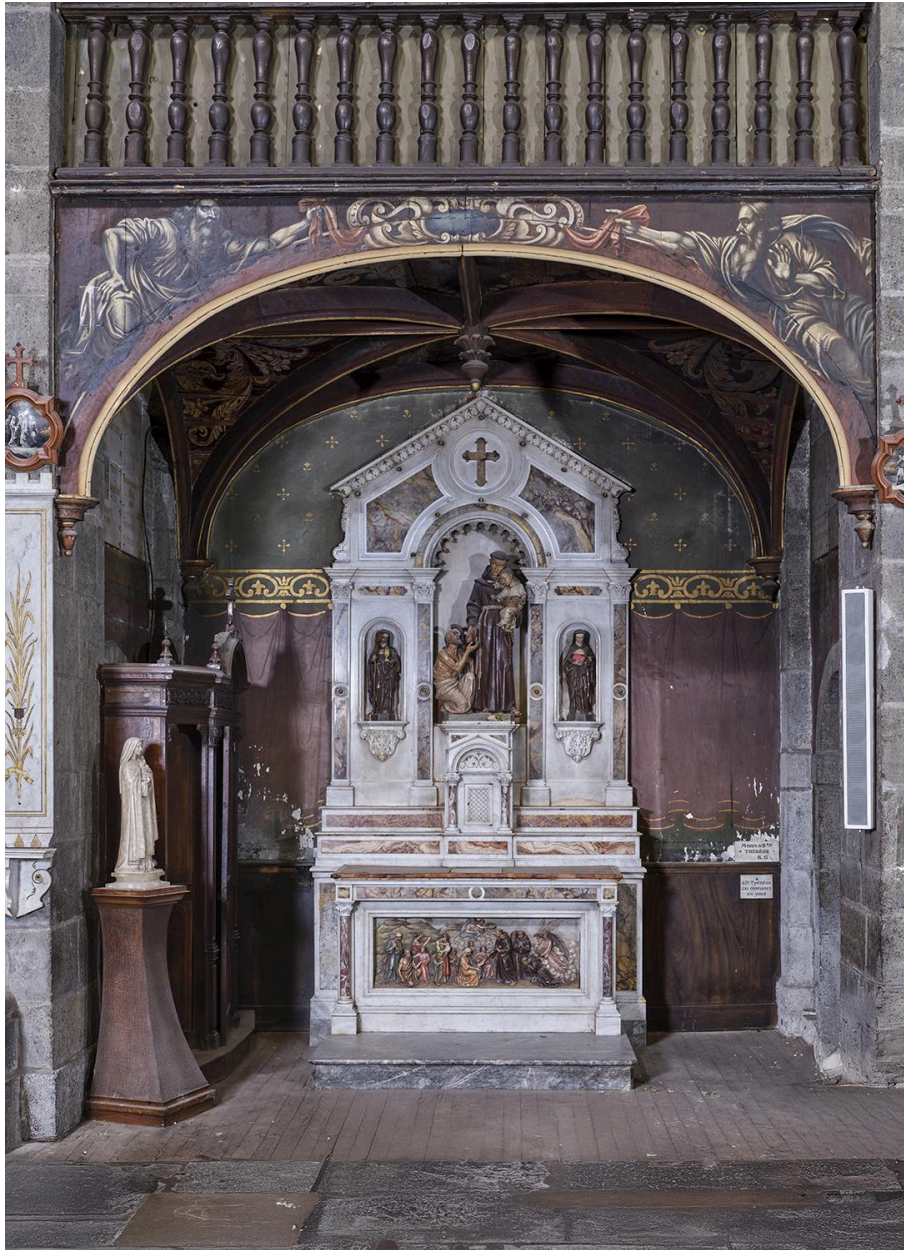
Bas-côté nord : chapelle Saint-Antoine de Padoue : vue d'ensemble
