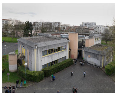
Bloc scientifique, vue d'ensemble depuis l'ouest Phot. Eric Dessert IVR84_20176900500NUCA
