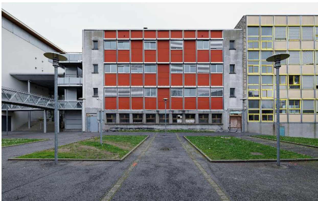
Infirmierie, élévation postérieure
