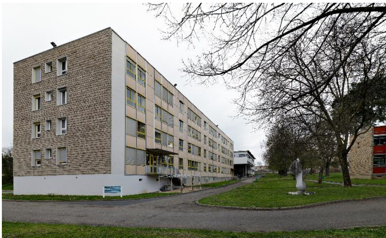
Internat, vue d'ensemble depuis le sud-est
