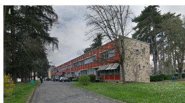
Bâtiment de l'administration, vue d'ensemble depuis le sud-est Phot. Eric Dessert IVR84_20176900502NUCAQ
