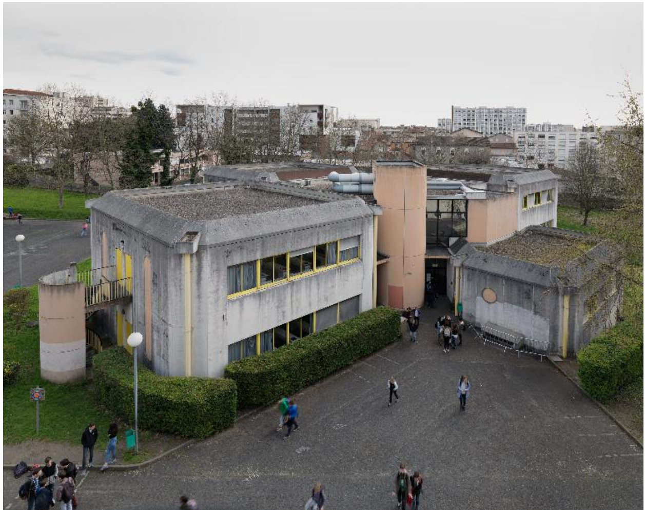
Bloc scientifique, vue d'ensemble depuis l'ouest
