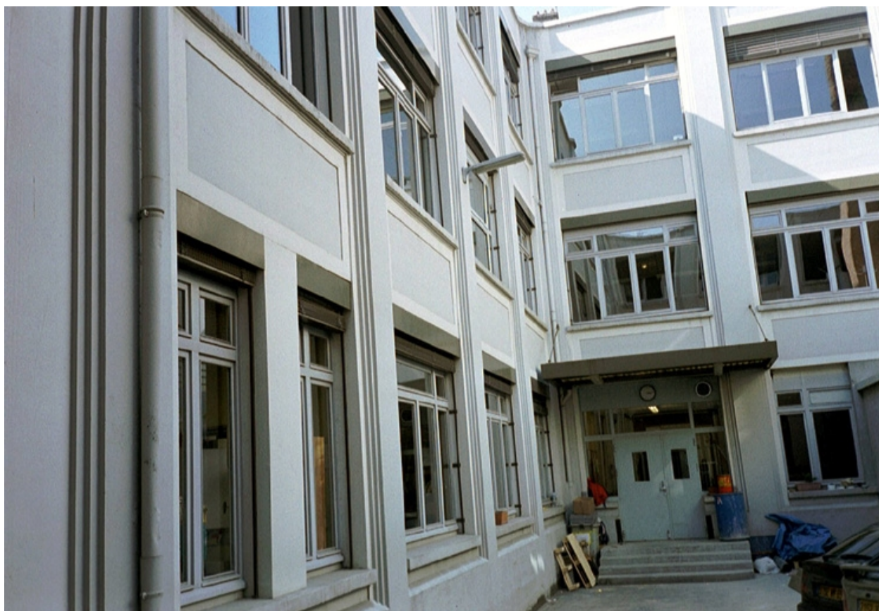
Vue nord-ouest de la cour intérieure
