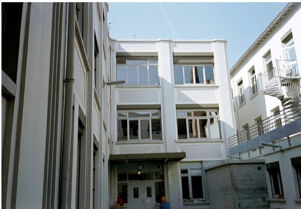
Vue de la cour intérieure
