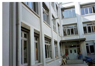
Vue nord-ouest de la cour intérieure Phot. Nadine Halitim-Dubois IVR82_20036901660NUCA
