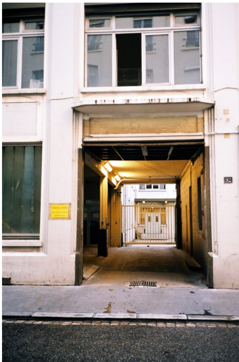
Entrée nord rue de Montesquieu
