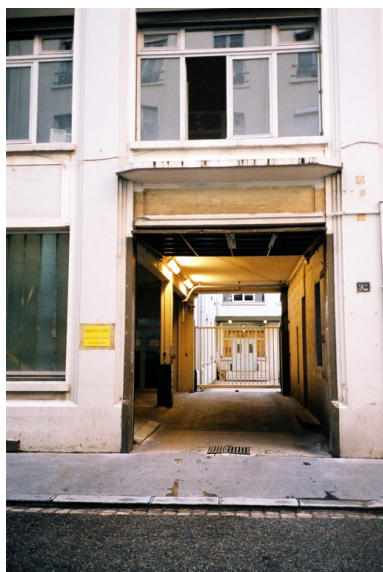
Entrée nord rue de Montesquieu Phot. Nadine Halitim-Dubois IVR82_20036901663NUCA
