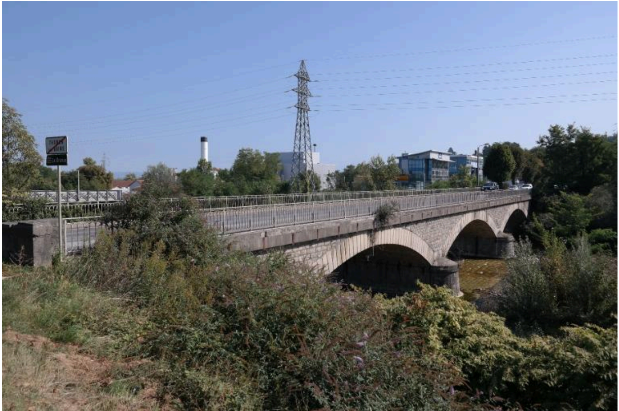
Vue générale du pont de Dranse
