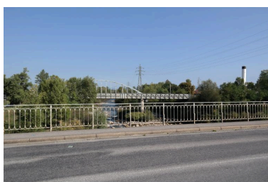
Vue du pont ferroviaire de Vongy depuis le Pont de Dranse Phot. Pascale Renard IVR84_20207401612NUCA
