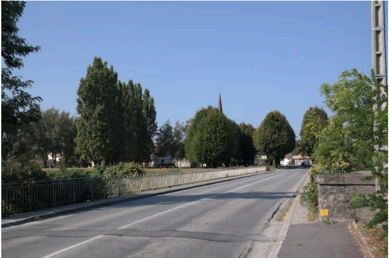
Pont de Dranse, vue de la chaussée
