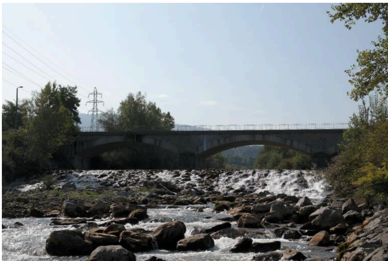
Pont de Dranse, vue de la face aval
