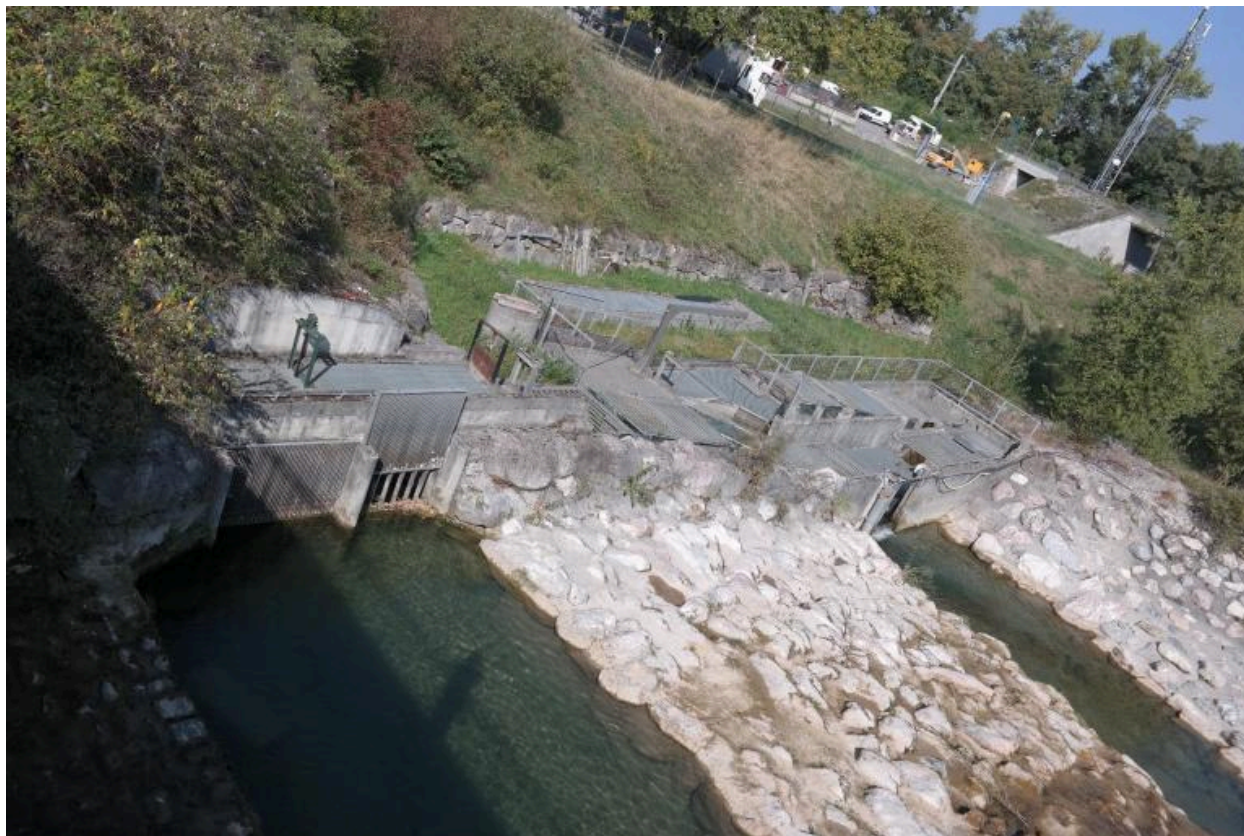
Pont de Dranse, la passe à poisson
