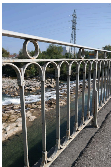
Pont de Dranse, détail des garde-corps Phot. Pascale Renard IVR84_20207401611NUCA
