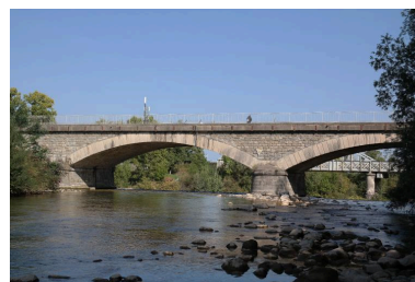
Pont de Dranse, vue de la face amont Phot. Pascale Renard IVR84_20207401607NUCA
