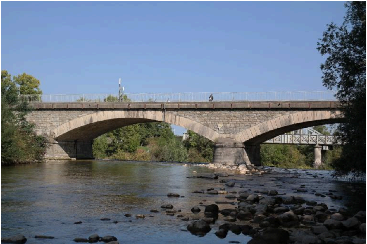
Pont de Dranse, vue de la face amont
