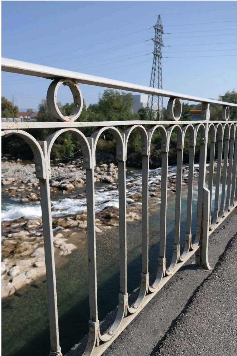
Pont de Dranse, détail des garde-corps
