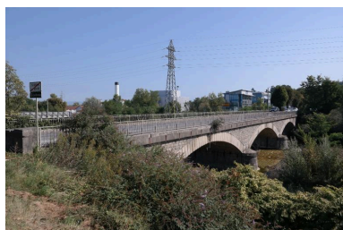
Vue générale du pont de Dranse Phot. Pascale Renard IVR84_20197401226NUCA
