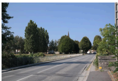
Pont de Dranse, vue de la chaussée Phot. Pascale Renard IVR84_20207401606NUCA
