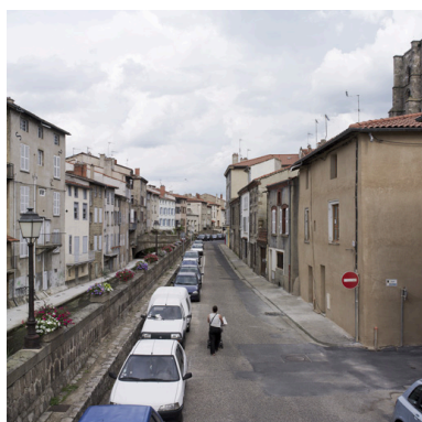
Quai L'Astrée, à gauche du Vizézy, maisons de types 1 et 2 construites en soubassement. Phot. Didier Gourbin IVR82_20074200217NUCA
