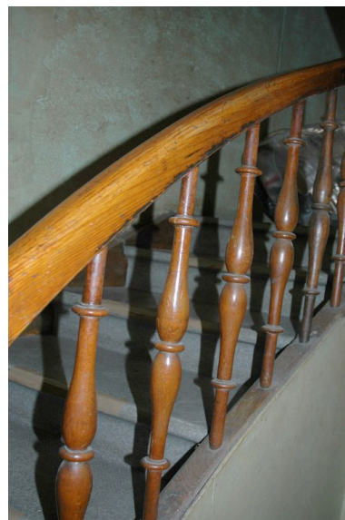
Garde-corps de la rampe d'escalier avec barreaux en bois tourné à fuseaux, 12 quai L'Astrée. Phot. Simone Hartmann-Nussbaum IVR82_20114201347NUCA
