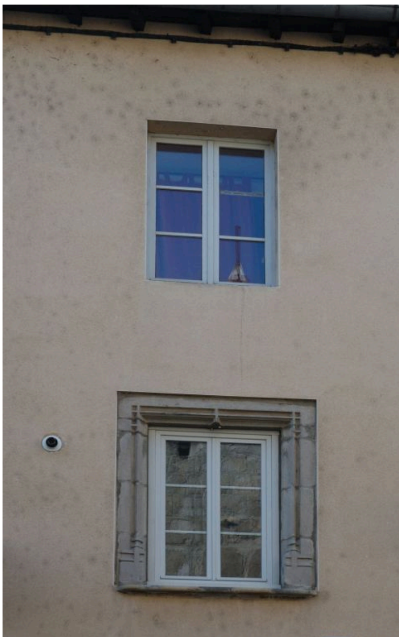
Vestige d'une ancienne fenêtre à croisée moulurée, 12-14 rue Marguerite-Fournier.
