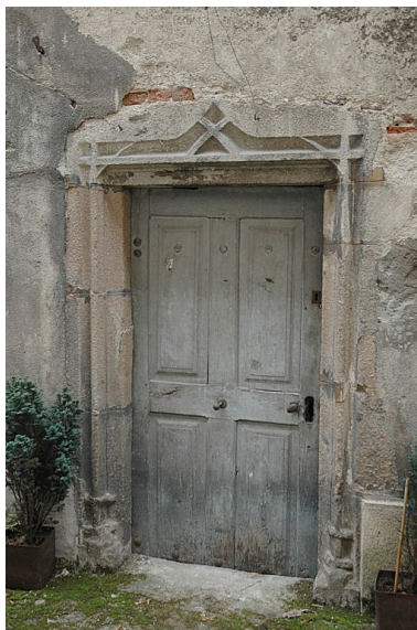
Encadrement de porte datable du 16e siècle, 23 rue Puy de la Bâtie. Phot. Simone Hartmann-Nussbaum IVR82_20114200274NUCA
