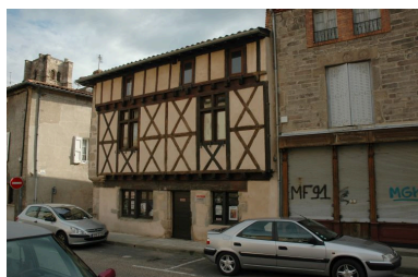
Maison à pan de bois, quai L'Astrée. Phot. Simone Hartmann-Nussbaum IVR82_20114201342NUCA
