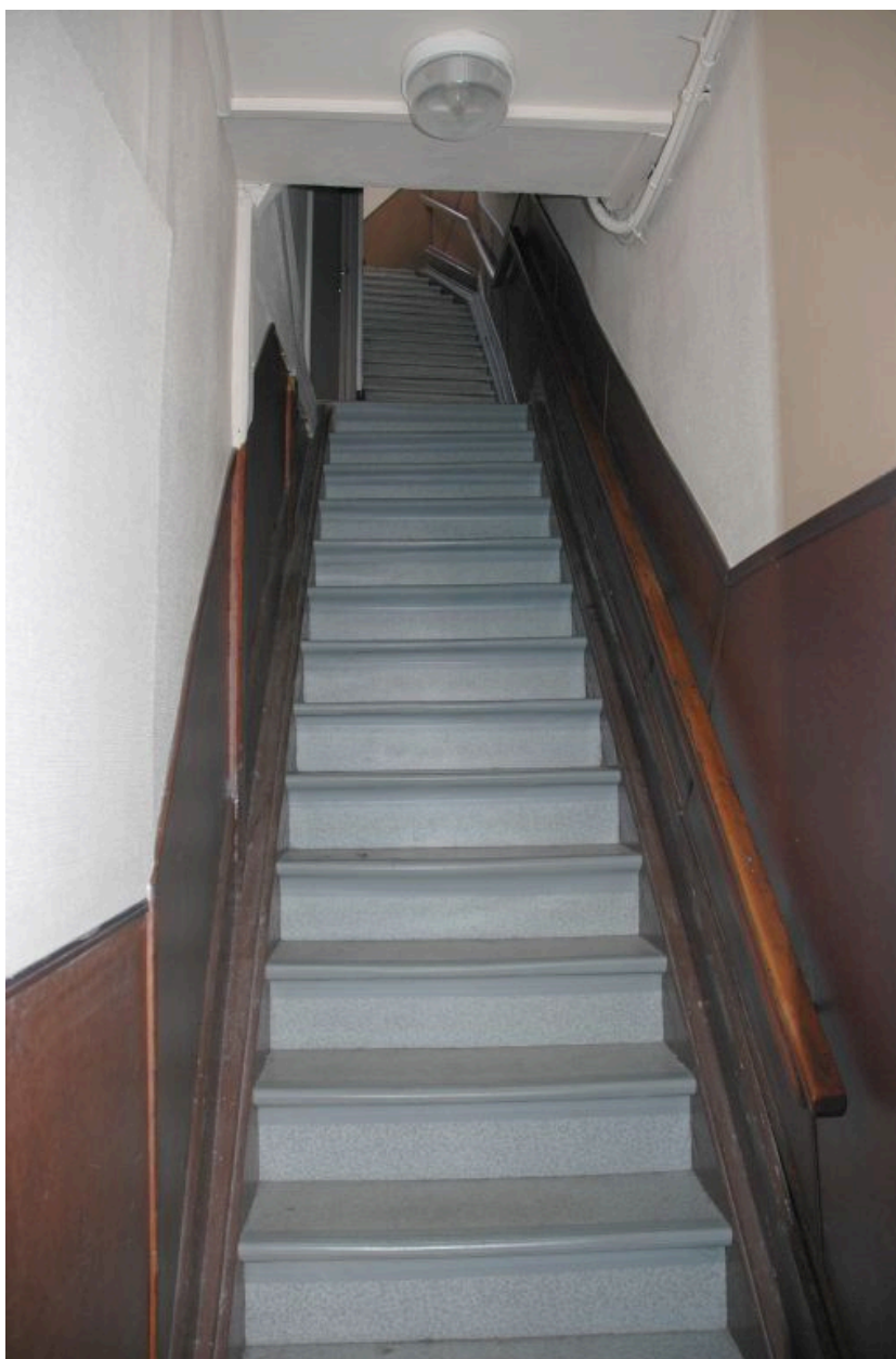
Escalier droit en bois, entre-murs, situé 26 rue Saint-Jean. Type d'escalier utilisé dans les maisons de types 1 et 2.
