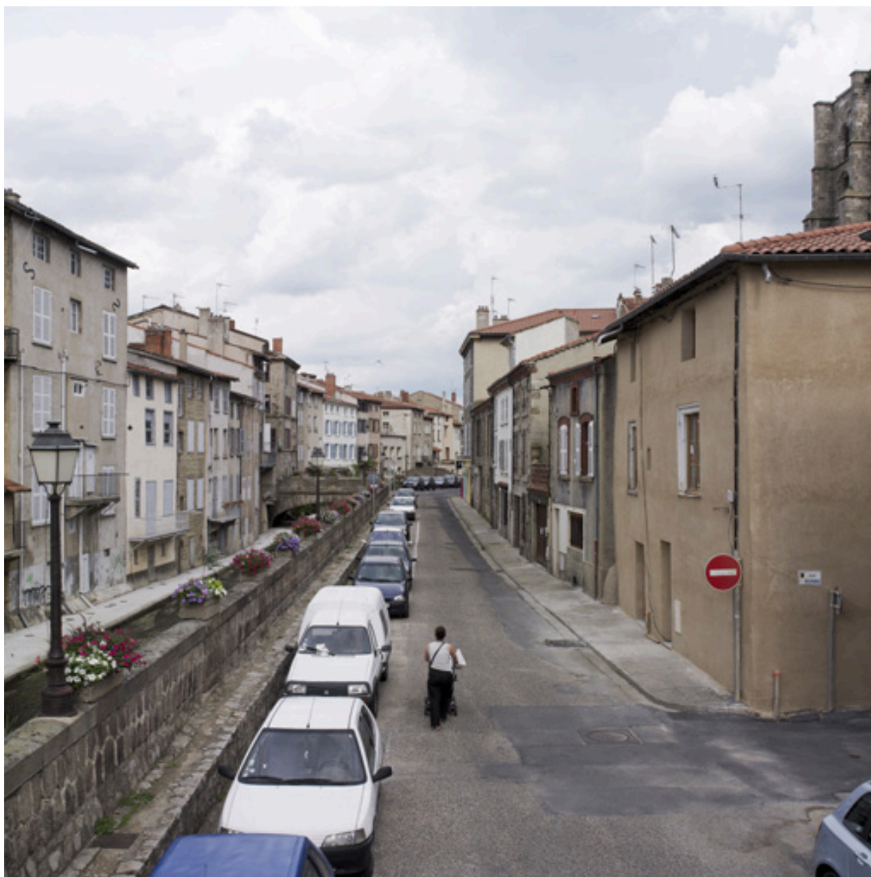
Quai L'Astrée, à gauche du Vizézy, maisons de types 1 et 2 construites en soubassement.
