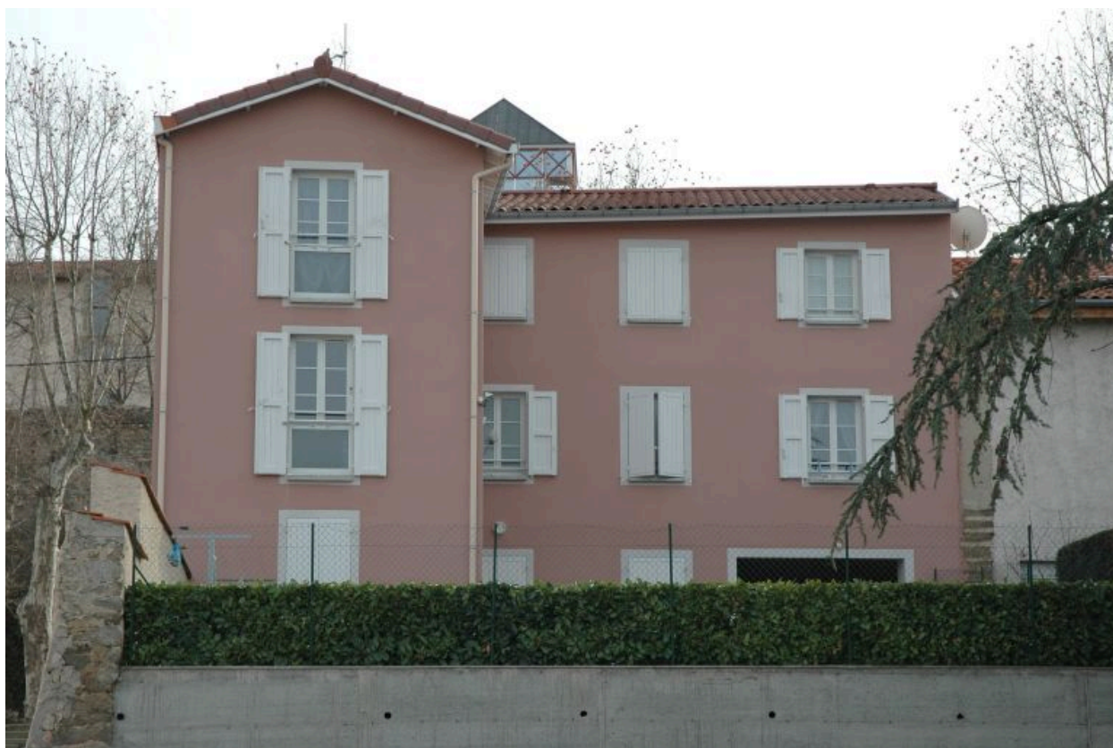
Maison de type 4 située 18-20 boulevard Duguet.
