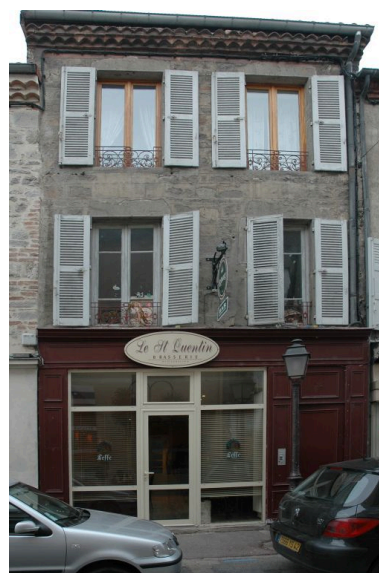
Maison avec boutique, 32 rue Marguerite-Fournier. Phot. Simone Hartmann-Nussbaum IVR82_20114202315NUCA
