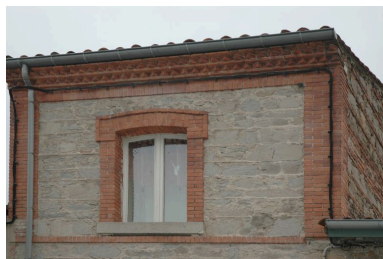
Utilisation de la brique dans la construction : encadrement d'ouverture, chaîne d'angle, corniche à denticules, 7 rue Bourgneuf. Phot. Simone Hartmann-Nussbaum IVR82_20114201243NUCA
