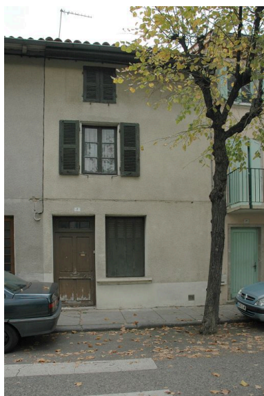
Maison de type 1 située 7 boulevard Lachèze. Phot. Simone Hartmann-Nussbaum IVR82_20114201362NUCA
