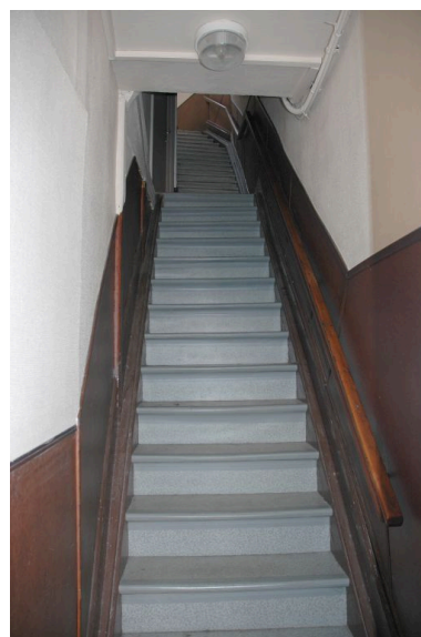
Escalier droit en bois, entre- murs, situé 26 rue Saint-Jean. Type d'escalier utilisé dans les maisons de types 1 et 2. Phot. Simone Hartmann-Nussbaum IVR82_20124201232NUCA
