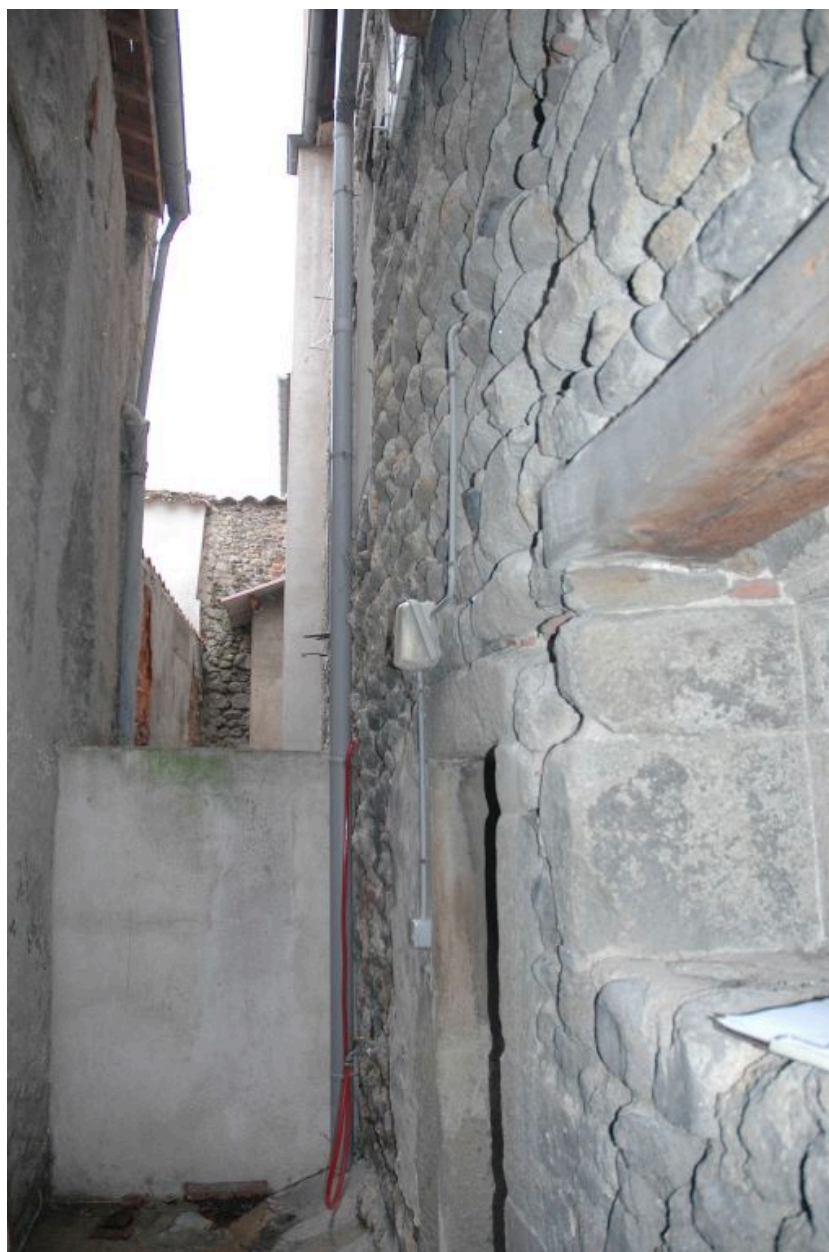
Elévations postérieures de maisons de types 1 et 2 donnant sur une ruelle latrinale, dans l'îlot Cordeliers-Précomtal.
