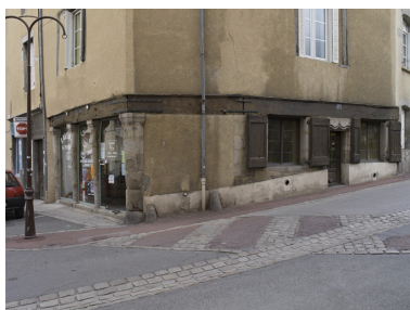
Rez-de-chaussée porté par une sablière, 1 rue Saint-Pierre. Phot. Eric Dessert IVR82_20084200618NUCA
