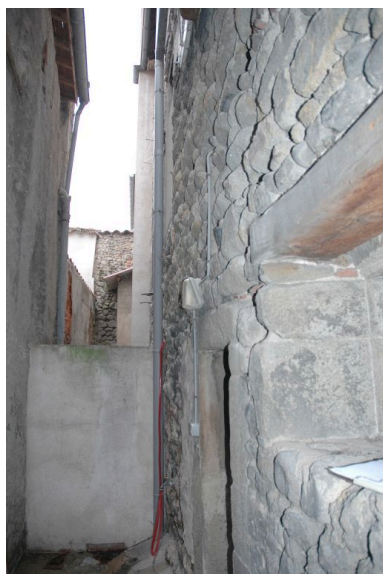
Elévations postérieures de maisons de types 1 et 2 donnant sur une ruelle latrinale, dans l'îlot Cordeliers-Précomtal. Phot. Simone Hartmann-Nussbaum IVR82_20114201254NUCA
