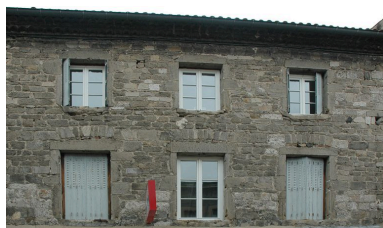
Partie haute d'une maison en moellon de granite, couronnée d'une génoise, 19 rue Saint-Jean. Phot. Simone Hartmann-Nussbaum IVR82_20124201337NUCA
