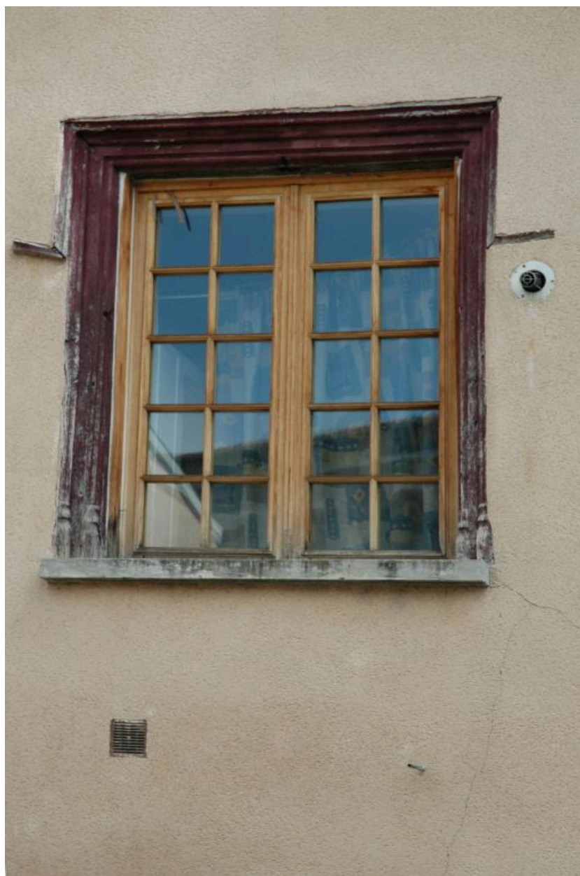
Vestige d'une ancienne croisée en bois, 8 place des Combattants.
