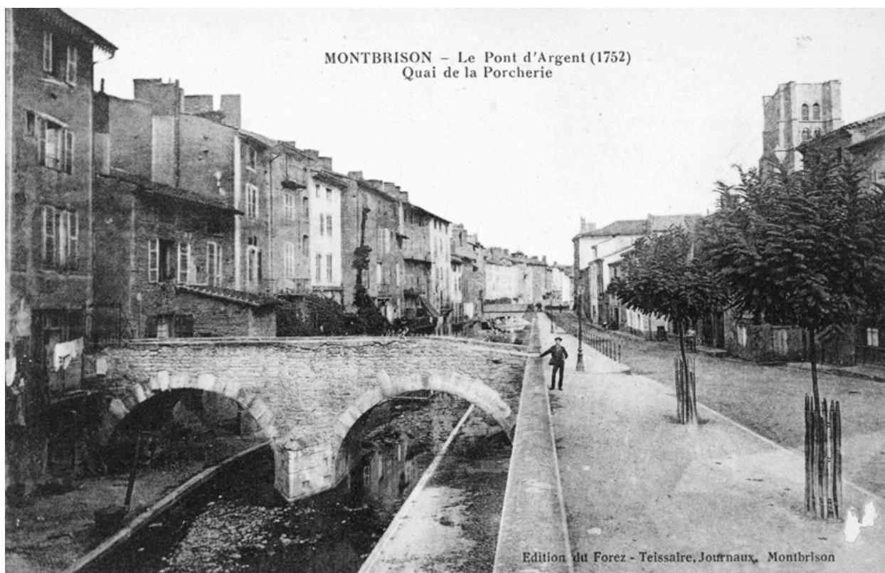
MONTBRISON - Le Pont d'Argent (1752). Quai de la Porcherie. Carte postale, début 20e siècle, éd. du Forez - Teissaire.
