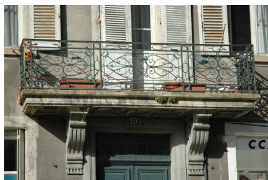
Balcon ornant l'élévation principale d'une maison de type 3, située 10 rue Notre-Dame. Phot. Simone Hartmann-Nussbaum IVR82_20114201312NUCA
