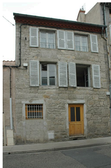
Maison en pierre de taille, 25 rue des Pénitents. Phot. Simone Hartmann-Nussbaum IVR82_20124201295NUCA
