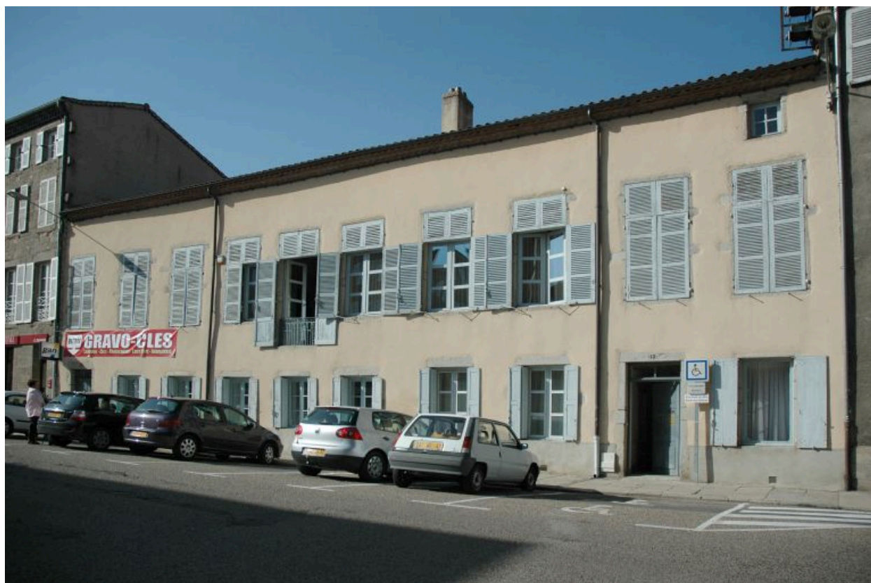
Maison de type 3, ancienne maison de chanoine située 12-14 rue Notre-Dame.
