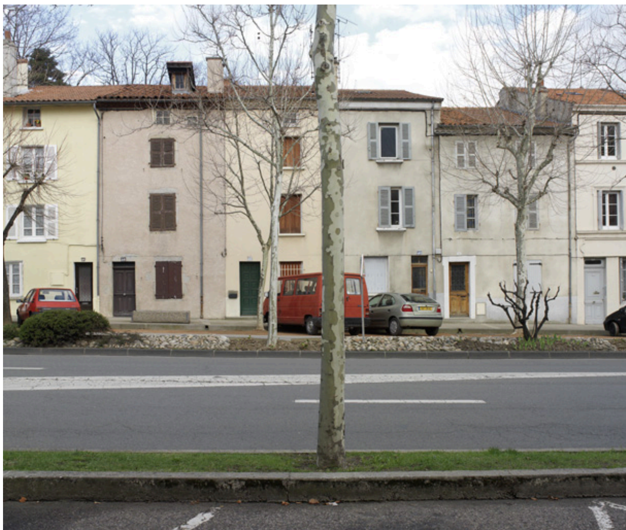
Boulevard de la Préfecture, maisons traversantes, type 1.
