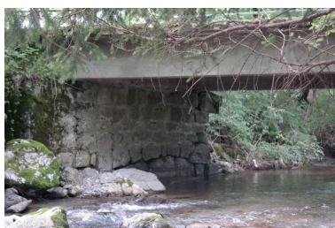
Pont du Moulin, détail culée Phot. Pascale Renard IVR84_20207400916NUCA
