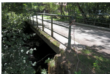
Vue d'ensemble du pont du Moulin Phot. Pascale Renard IVR84_20197401197NUCA
