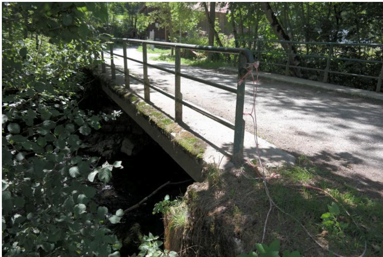
Vue d'ensemble du pont du Moulin
