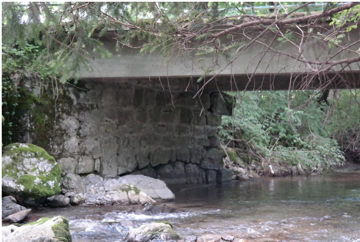
Pont du Moulin, détail culée
