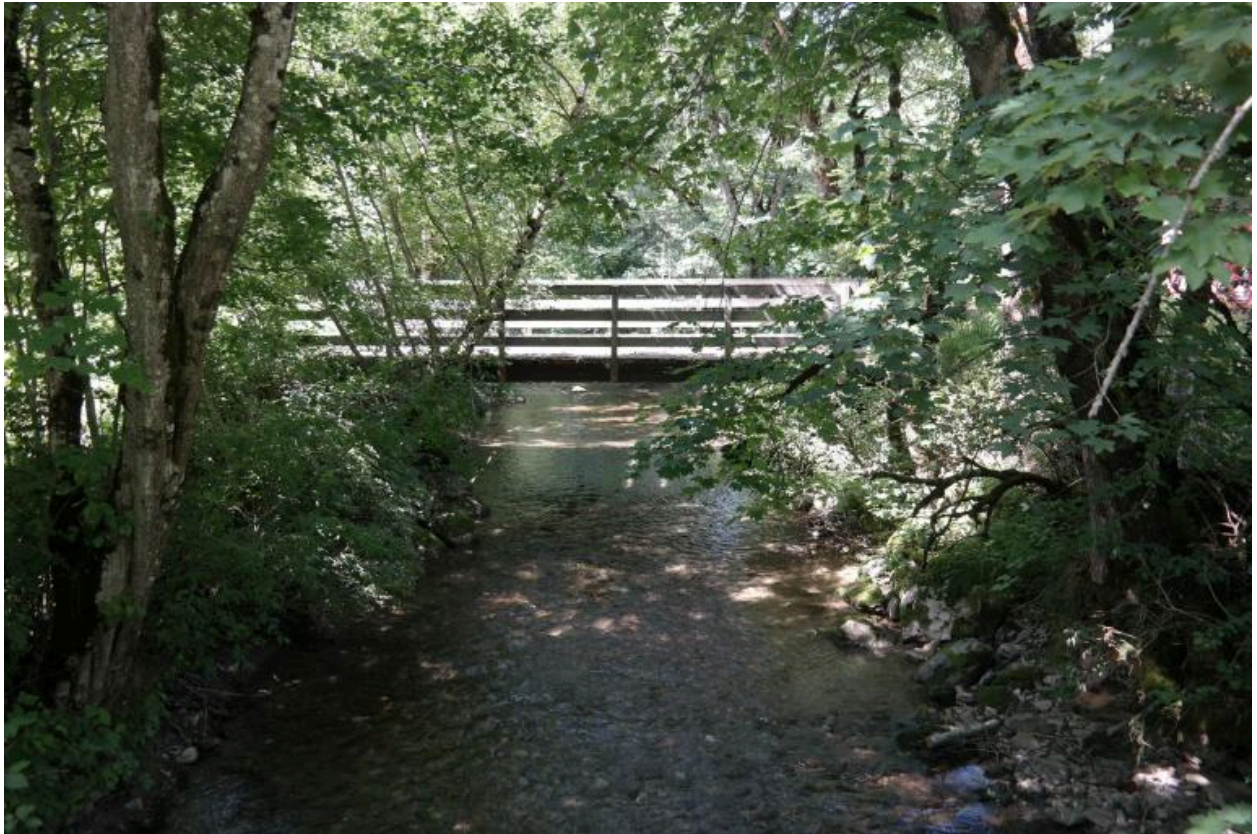
Pont du Moulin, face aval
